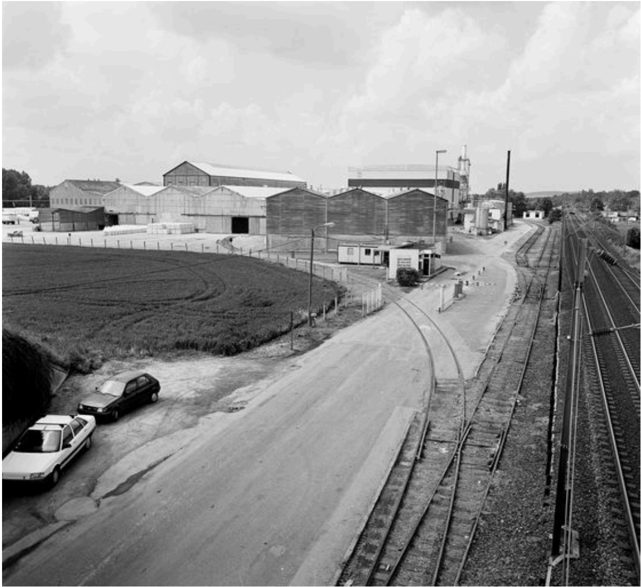
Vue d'ensemble nord.
