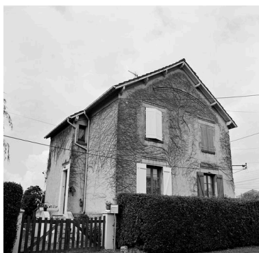
Logement d'ouvriers. Phot. Olivier Coquelle IVR22_19946001216X
