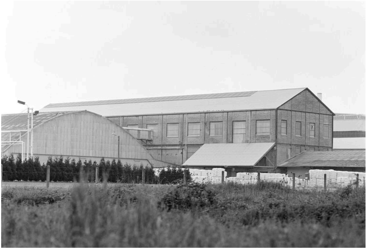
Vue d'ensemble est.
