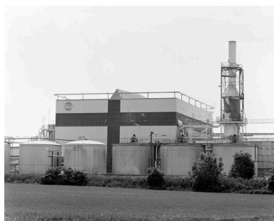
Vue d'ensemble sud-est. Phot. Olivier Coquelle IVR22_19946000926X
