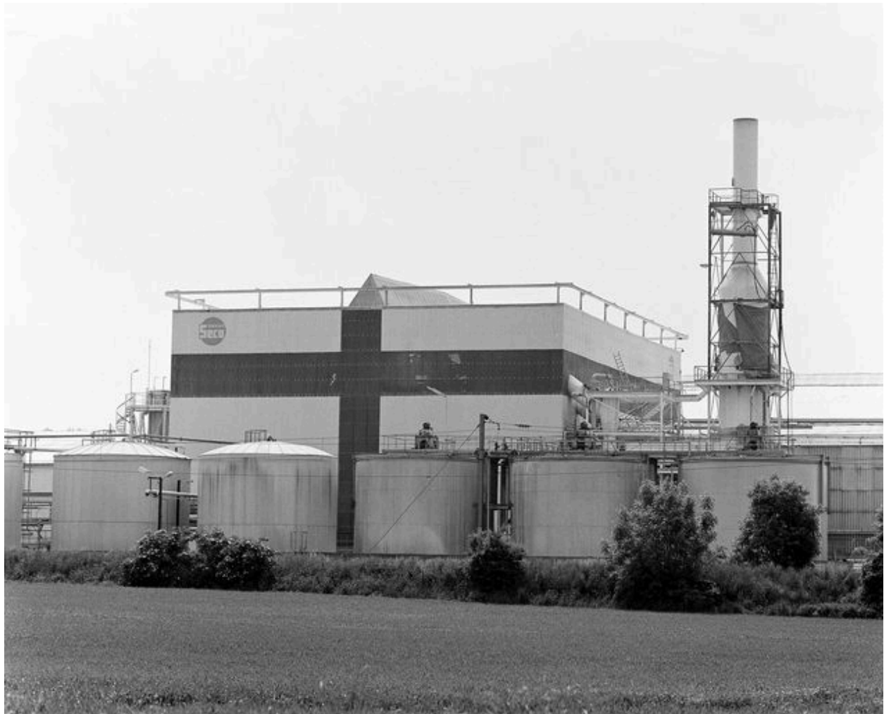
Vue d'ensemble sud-est.
