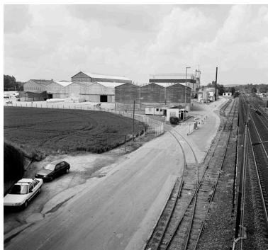
Vue d'ensemble nord. Phot. Olivier Coquelle IVR22_19946000925X
