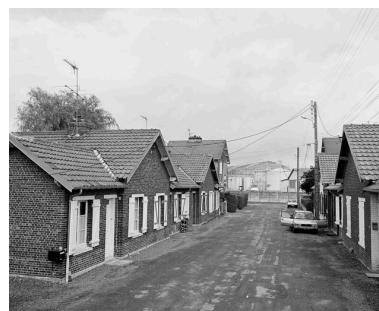
Logements d'ouvriers. Phot. Olivier Coquelle IVR22_19946001214X
