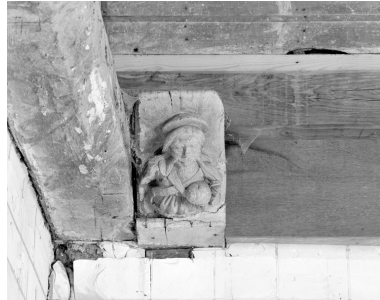
Blochets sculptés, 1ère travée nord : Dieu le Père tenant le globe. Phot. Irwin Leullier IVR22_20008000559X
