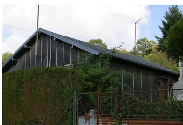
Vue d'une maison provisoire encore in situ. Phot. Inès Guérin IVR22_20030202037NUCA
