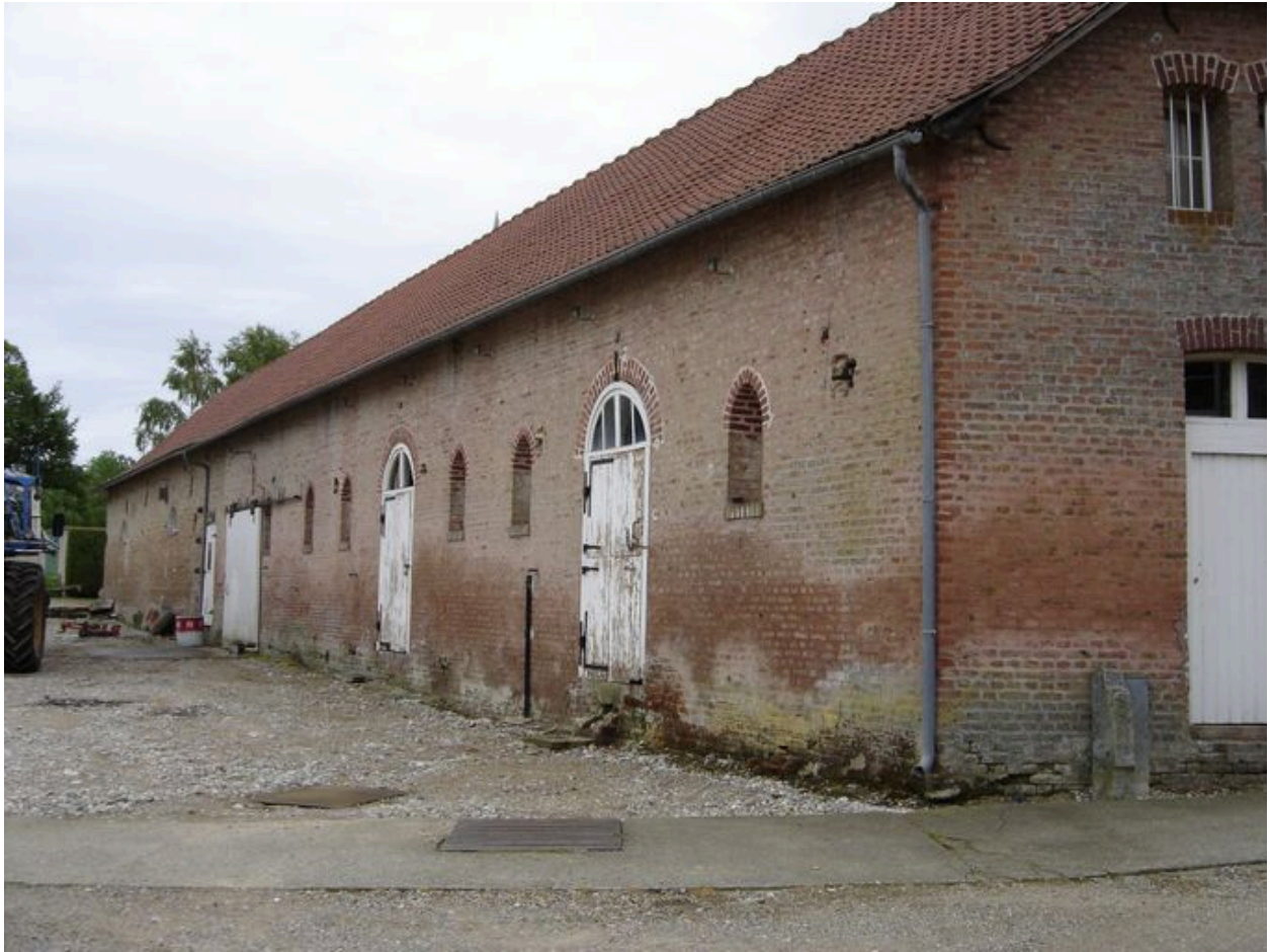
Face nord du bâtiment nord.
