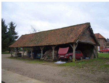
Vue de l'abri situé au nord de la propriété.
