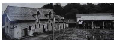
Vue d'une partie des bâtiments de la ferme en 1960. Phot. Inès Guérin IVR22_20068005577NUCAB
