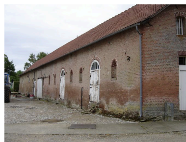
Face nord du bâtiment nord. Phot. Catherine Fourmond IVR22_20058001685NUCA
