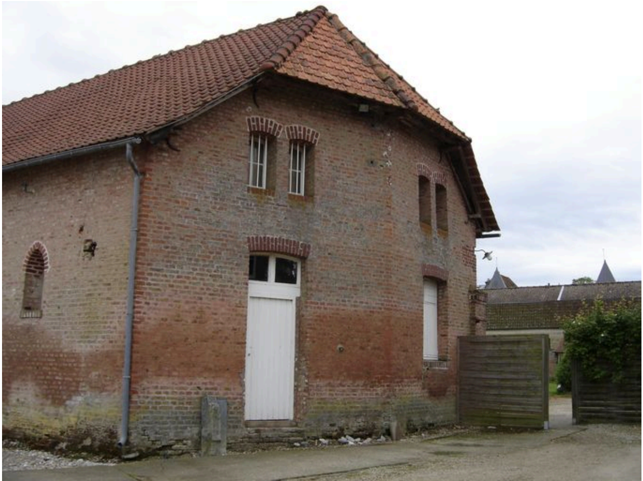
Pignon occidental du bâtiment nord.
