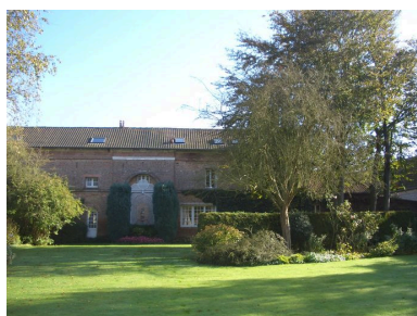
Vue postérieure du logis depuis le jardin de la maison carrée. Phot. Inès Guérin IVR22_20068005578NUCA
