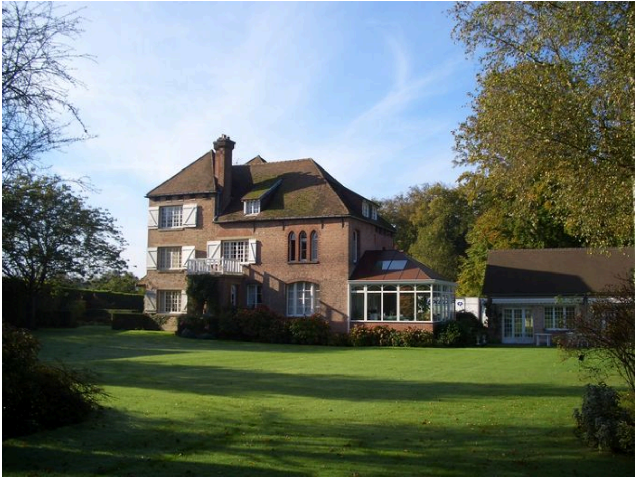
Vue de la maison carrée depuis le jardin.
