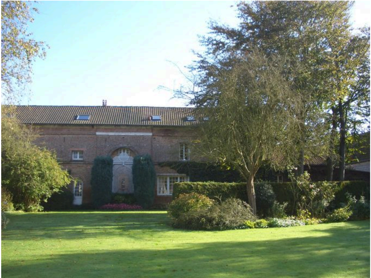
Vue postérieure du logis depuis le jardin de la maison carrée.
