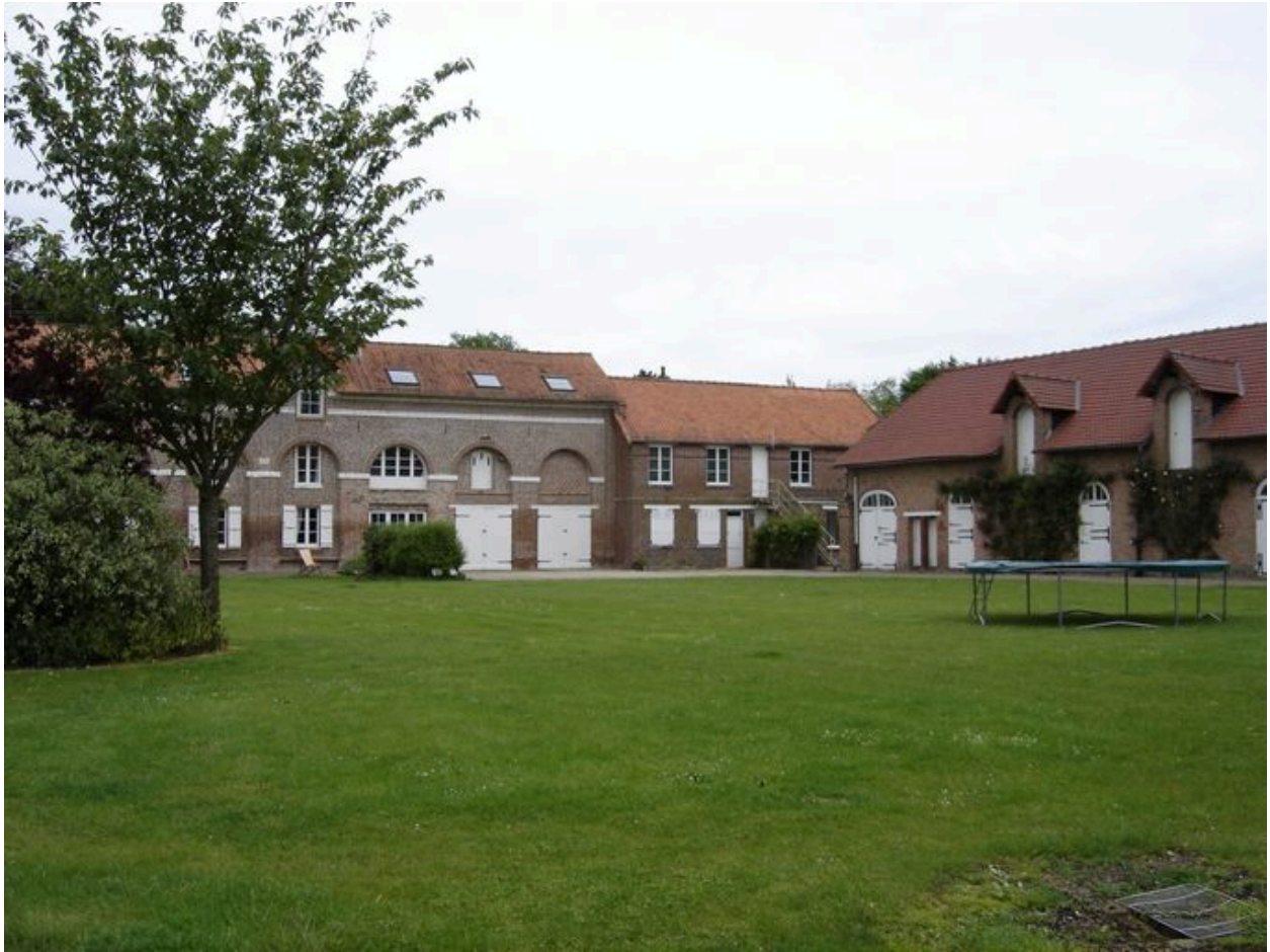
Vue sur l'angle nord-ouest de la cour.
