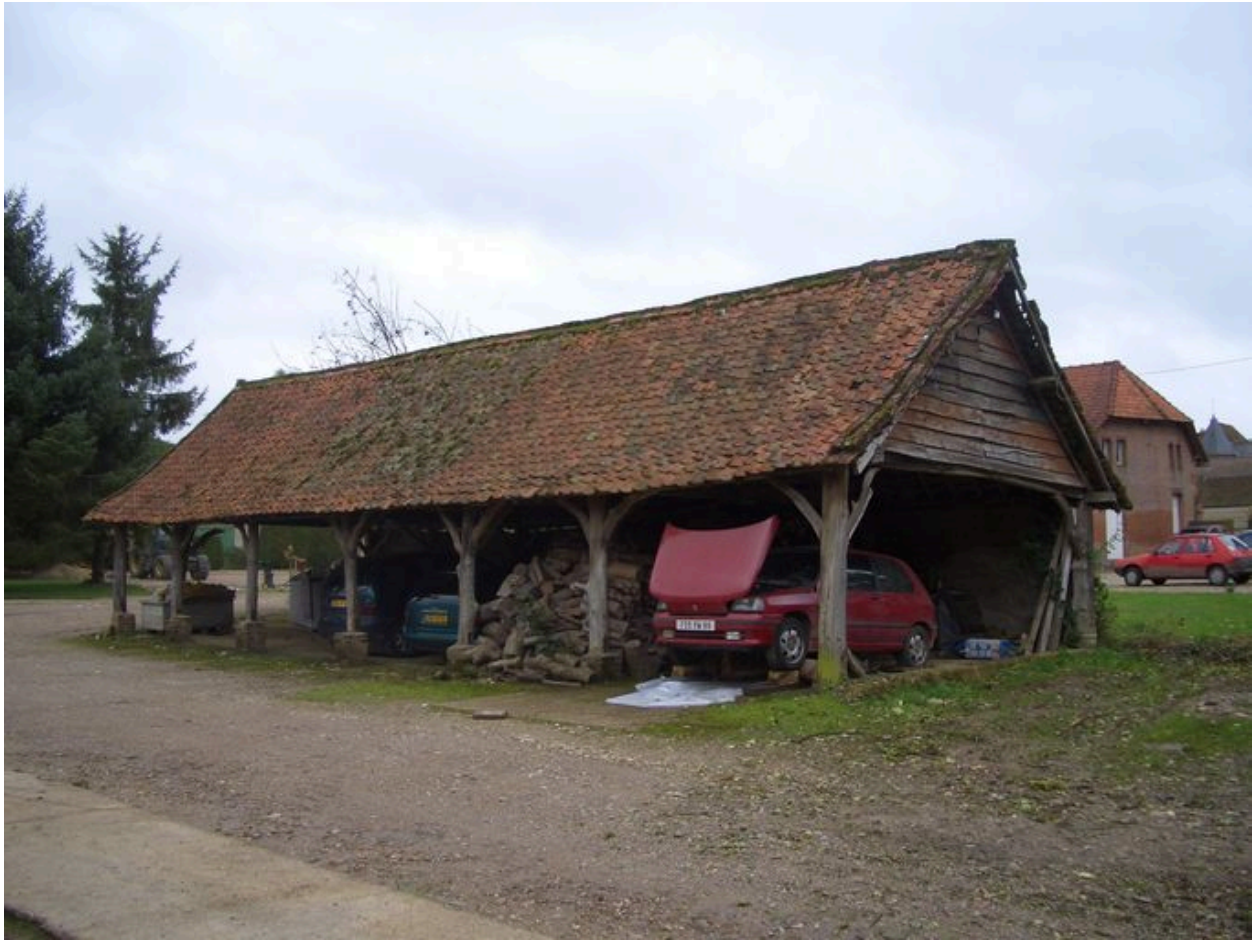
Vue de l'abri situé au nord de la propriété.
