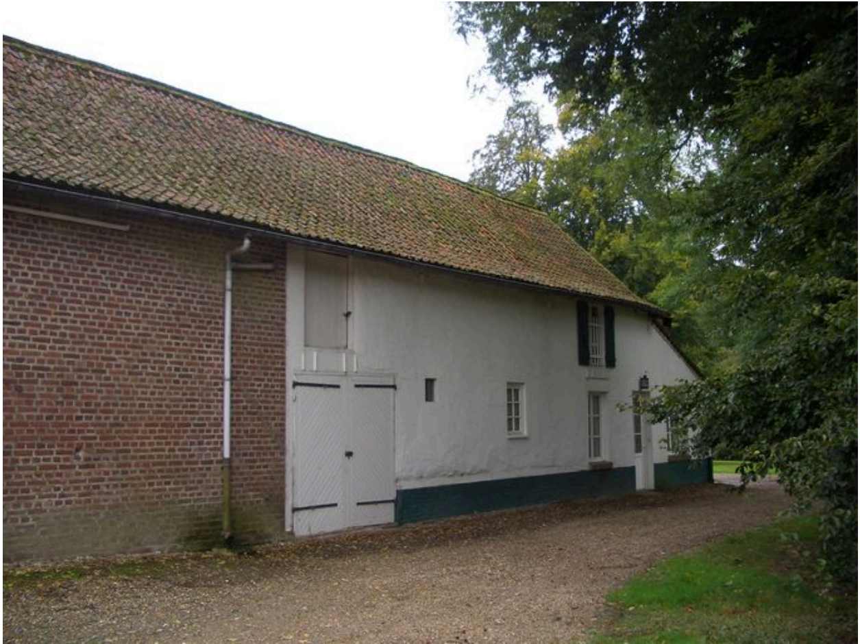
Vue du logis accolé aux bergeries.
