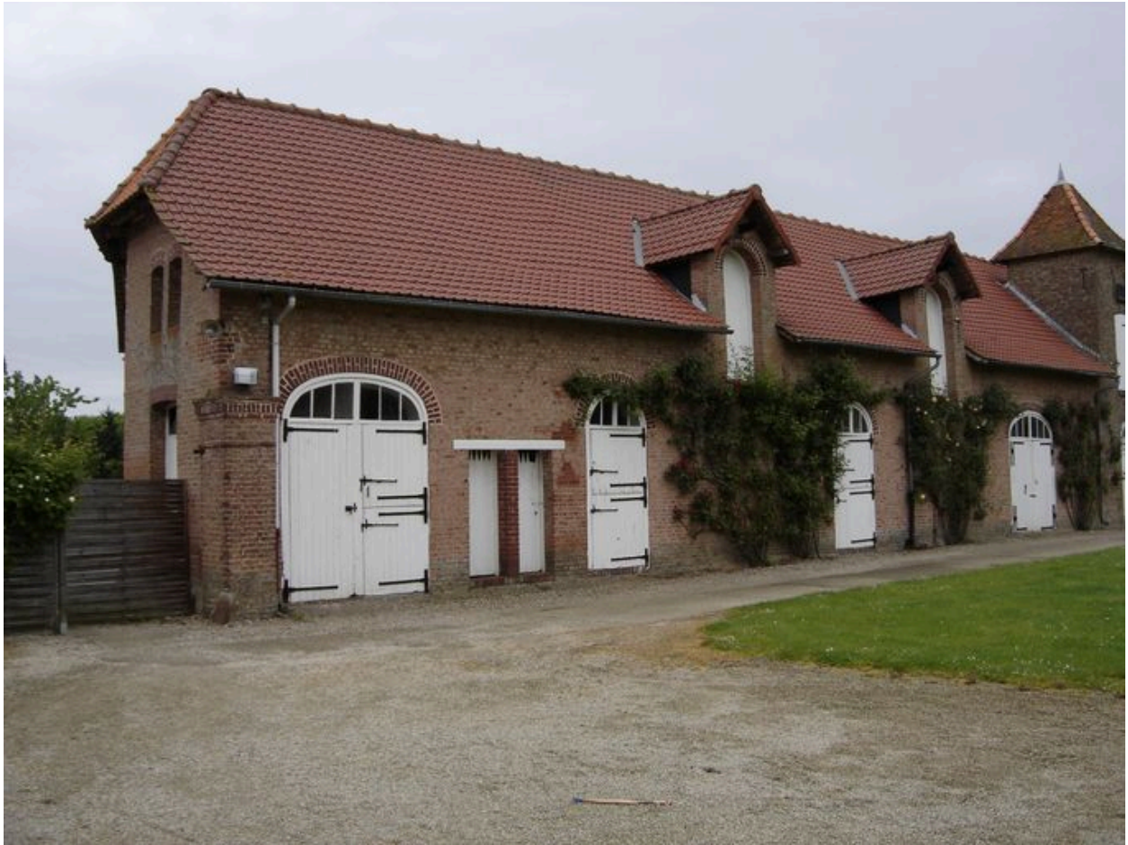
Détail de l'extrémité occidentale du bâtiment nord.
