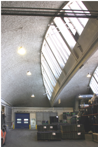
Ancien atelier de fabrication : un shed. Phot. Frédéric Pillet IVR22_20060205129NUCA
