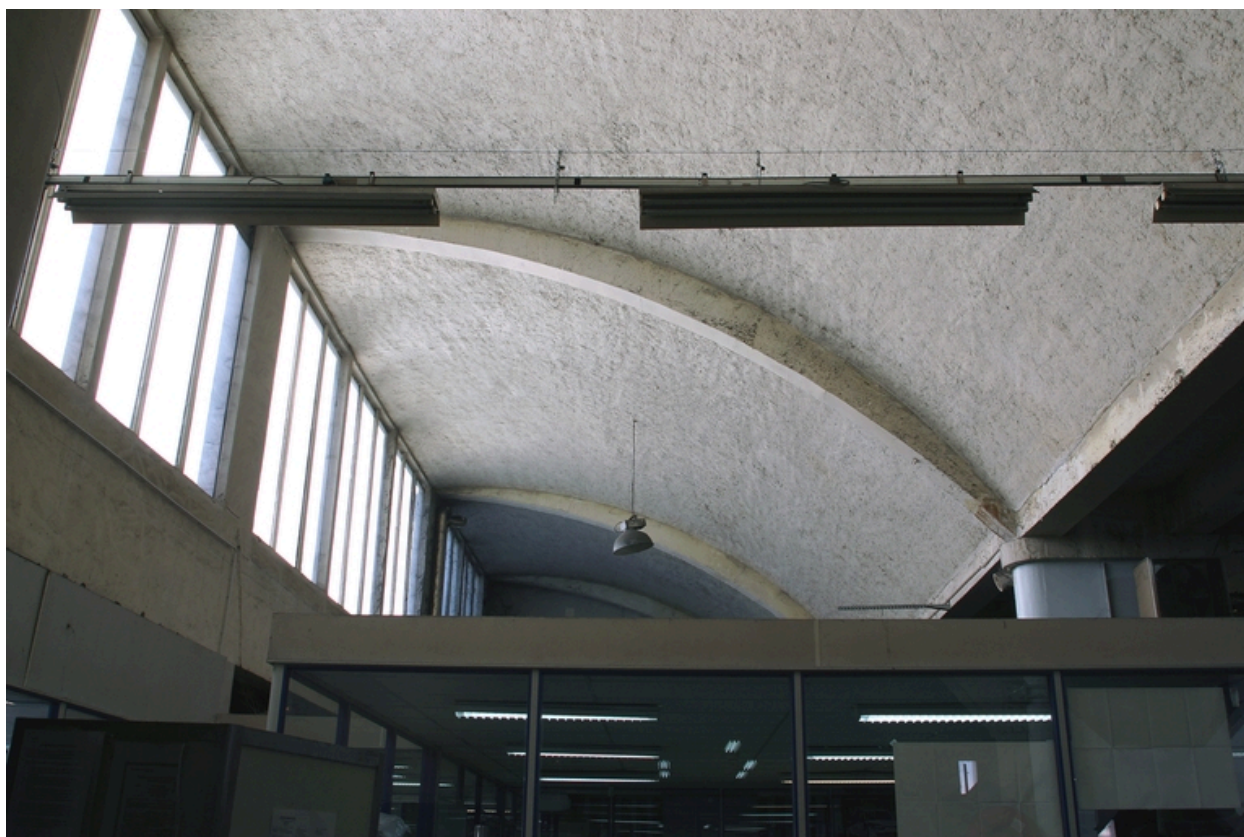
Voûtement de l'espace intermédiaire entre les bureaux et l'ancien atelier de fabrication.
