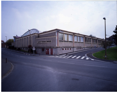
Façade de l'usine, rue Pierre-Sémard. Phot. Thierry Lefébure IVR22_20070200056VA
