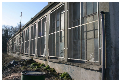
Façade latérale de l'atelier de tuft.
