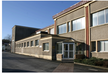
Cour de l'usine : entrée des bureaux. Phot. Frédéric Pillet IVR22_20060205124NUCA
