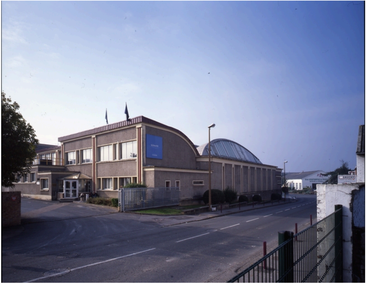
Façade de l'usine, rue Pierre-Semard.
