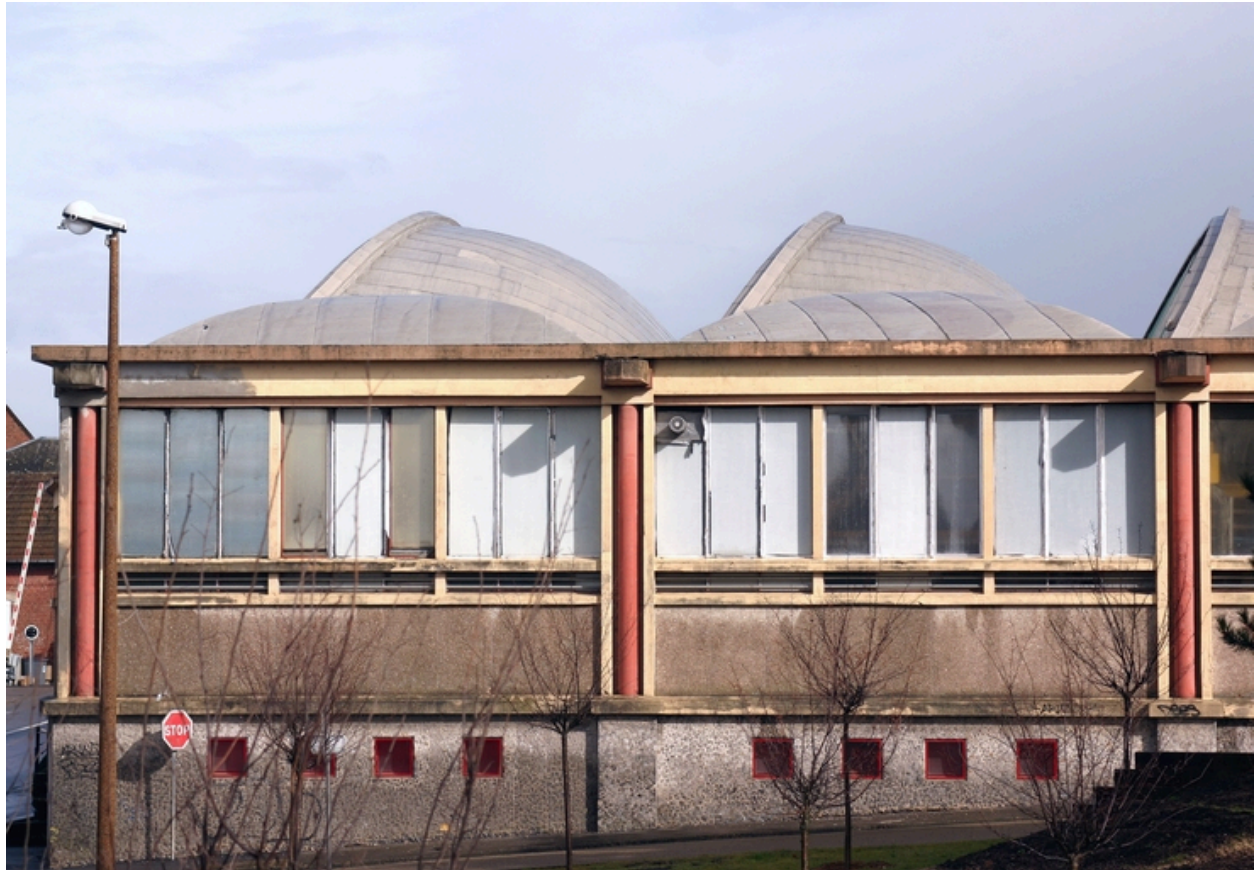
Détail de la façade, rue Ambroise-Croizat.
