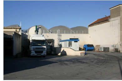
Actuel quai de chargement : au centre les sheds des ateliers, à droite l'ancienne salle des machines. Phot. Frédéric Pillet IVR22_20060205126NUCA
