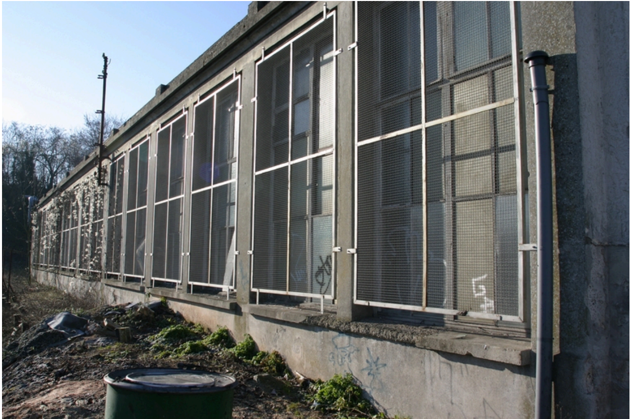
Façade latérale de l'atelier de tuft.
