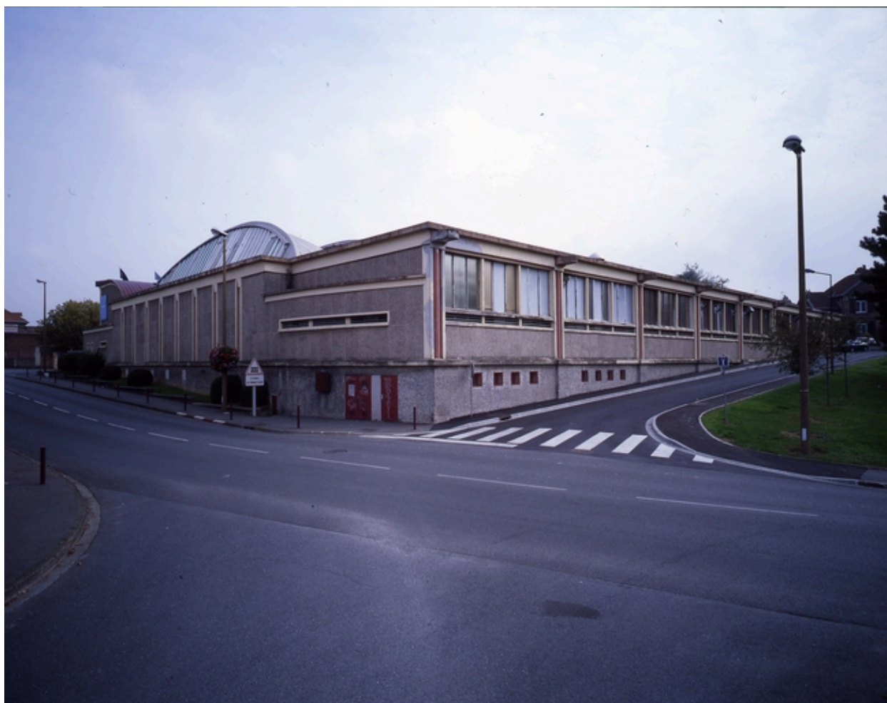
Façade de l'usine, rue Pierre-Semard.
