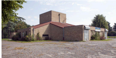
Élévation sud ouest. Phot. Pierre Thibaut IVR31_20155900720NUCA
