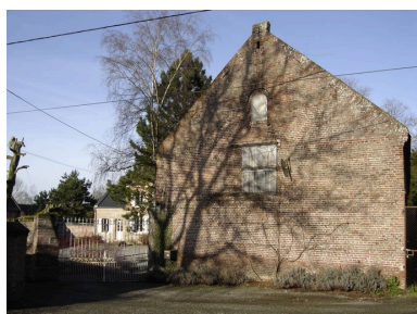
Vue du pignon des écuries depuis la rue. Phot. Inès Guérin IVR22_20068005522NUCA
