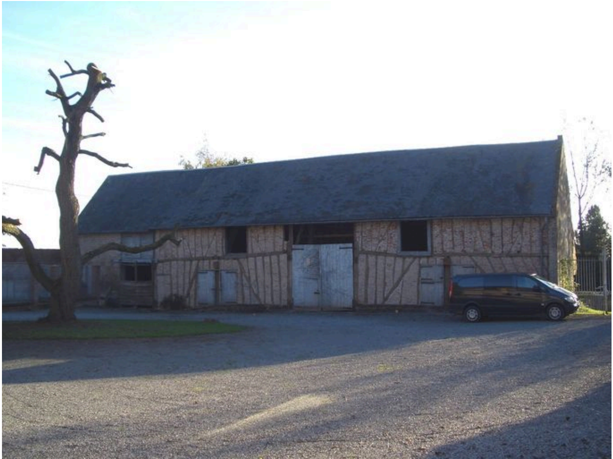
Vue de la grange au sud.
