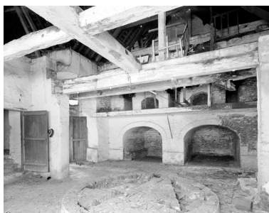
Ecuries et brasserie, vue intérieure. Phot. Patrick Glotain IVR22_19918000153V
