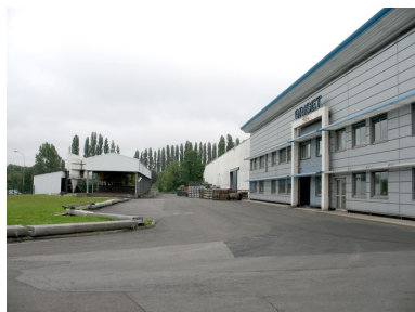
Le bâtiment administratif (au premier plan) et les hangars de stockage des métaux. Phot. Clarisse Lorieux IVR22_20096005183NUCA
