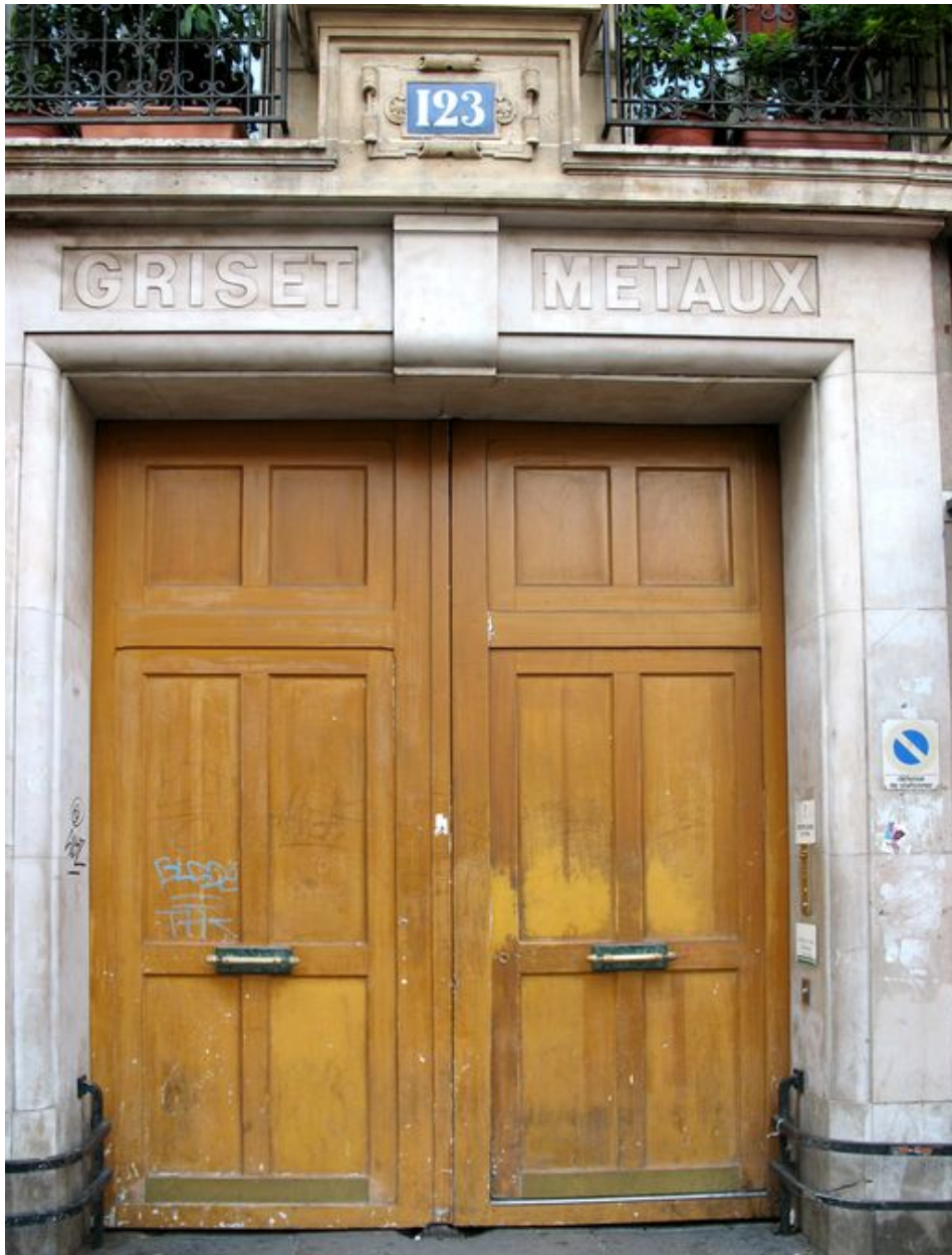
Porte d'entrée de l'immeuble haussmannien situé au 123 rue Oberkampf à Paris à l'emplacement de l'ancienne fonderie Griset.
