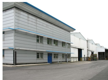
Les bureaux et les ateliers de fabrication. Phot. Clarisse Lorieux IVR22_20096005182NUCA
