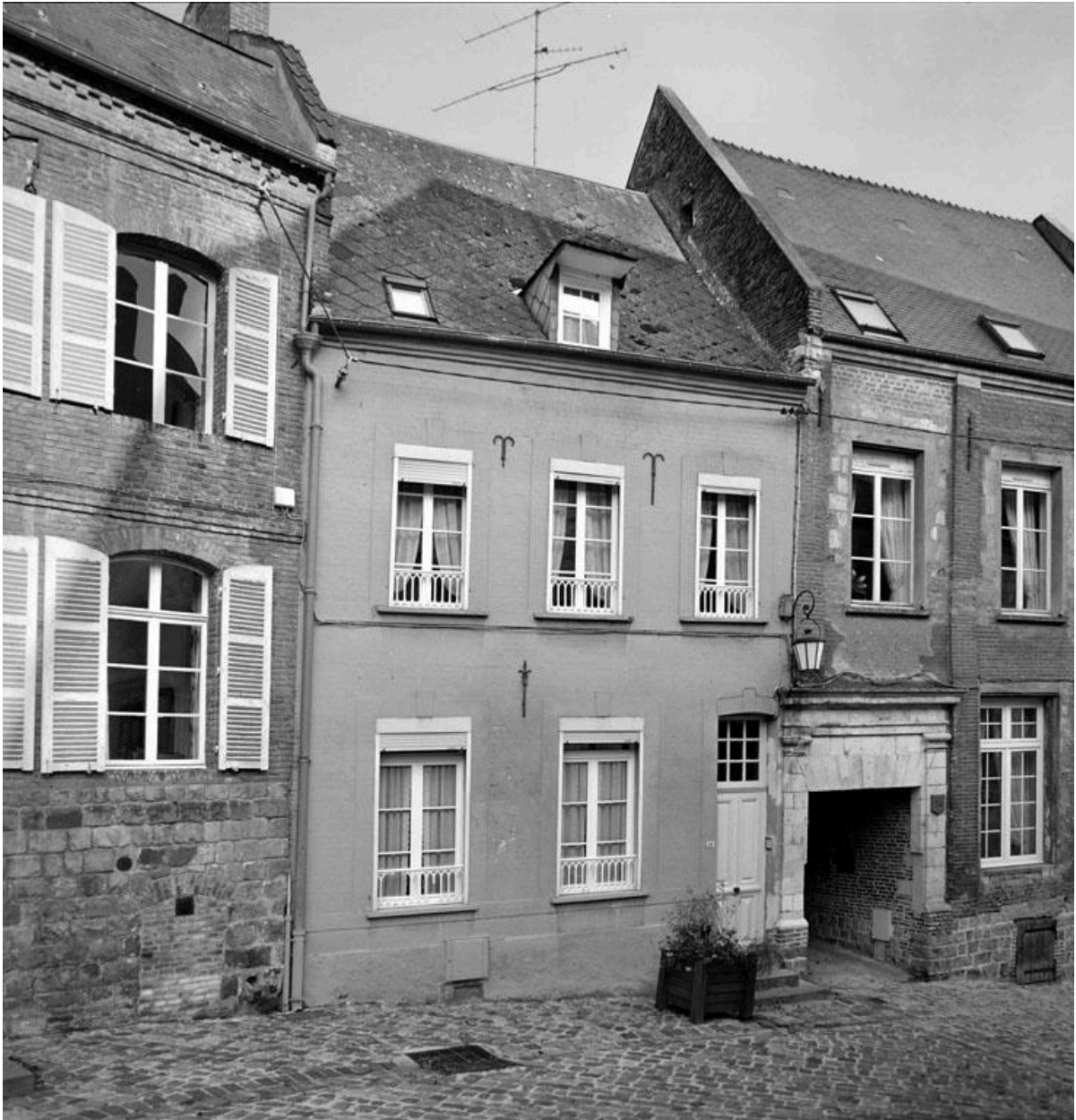
Vue de la façade sur rue.
