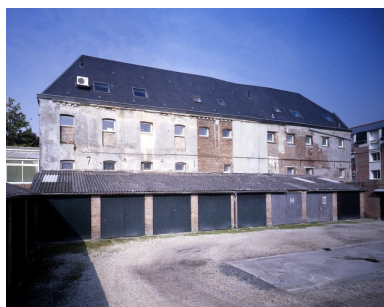
Ancien bâtiment conventuel puis atelier, vu du sud. Phot. Thierry Lefébure IVR22_20070200077VA
