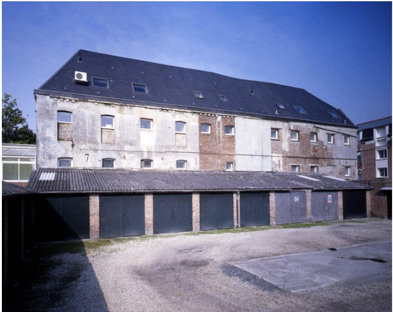
Ancien bâtiment conventuel puis atelier, vu du sud.
