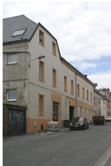
Façade antérieure, rue Michelet. Phot. Frédéric Pillet IVR22_20050206141NUCA
