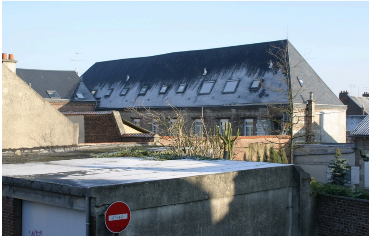
Vue des anciens bâtiments conventuels puis ateliers, depuis le nord-ouest.
