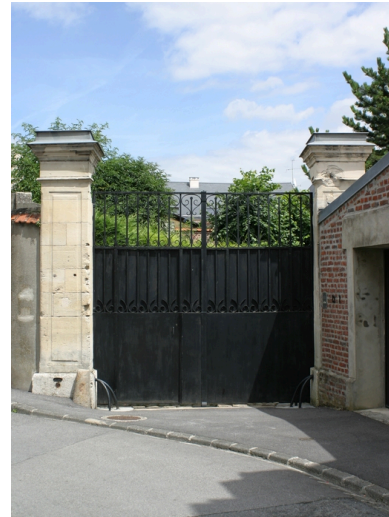
Ancien portail d'entrée du couvent puis du tissage, rue des Cordeliers. Phot. Frédéric Pillet IVR22_20050206147NUCA
