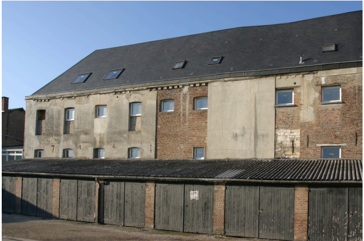
Ancien bâtiment conventuel puis atelier, vu du sud.
