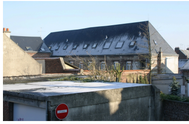
Vue des anciens bâtiments conventuels puis ateliers, depuis le nord-ouest. Phot. Frédéric Pillet IVR22_20050206145NUCA
