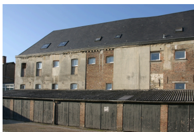
Ancien bâtiment conventuel puis atelier, vu du sud. Phot. Frédéric Pillet IVR22_20050206143NUCA
