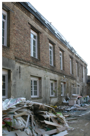
Vu de l'ancien bâtiment conventuel transformé en atelier, vu depuis la cour (ancien cloître). Phot. Frédéric Pillet IVR22_20050206144NUCA
