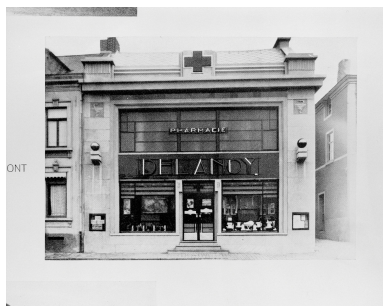
Vue de face, entre 1927 et 1934. In : DANIS Adolphe. Travaux d'architecture. [s. l.] : Edari éditions, [ca. 1935] (AP Dieux). Repro. Olivier Marlard IVR31_19925901759X
