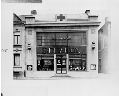
Vue de face, entre 1927 et 1934. In : DANIS Adolphe. Travaux d'architecture. [s. l.] : Edari éditions, [ca. 1935] (AP Dieux). Repro. Olivier Marlard IVR31_19925901759X
