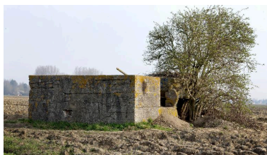
Vue de trois-quarts, vers le nord-est Phot. Jean-Marc Ramette IVR31_20145905516NUCA
