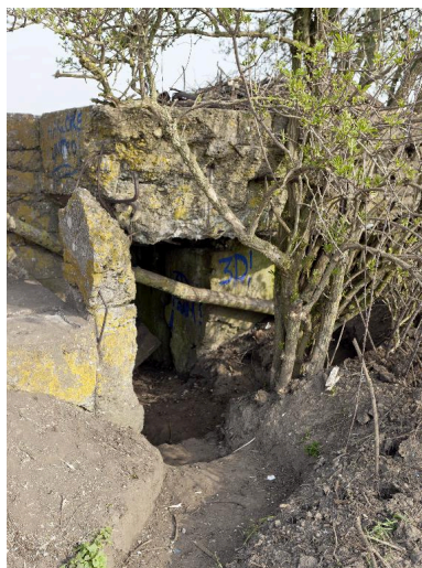
Elévation sud, accès à l'édifice Phot. Jean-Marc Ramette IVR31_20145905514NUCA
