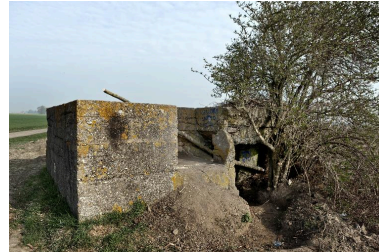
Elévation sud Phot. Jean-Marc Ramette IVR31_20145905513NUCA
