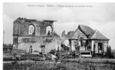
Vue de l'église en 1918 (AP). Phot. Jean-Michel Périn IVR22_19856000377XB
