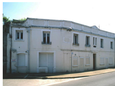
Ancien magasin avec logements dit Louise (132 rue de Saint-Valery).
