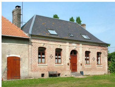
Logis de fond de cour. Phot. Frédéric Fournis IVR22_20108001415NUCA
