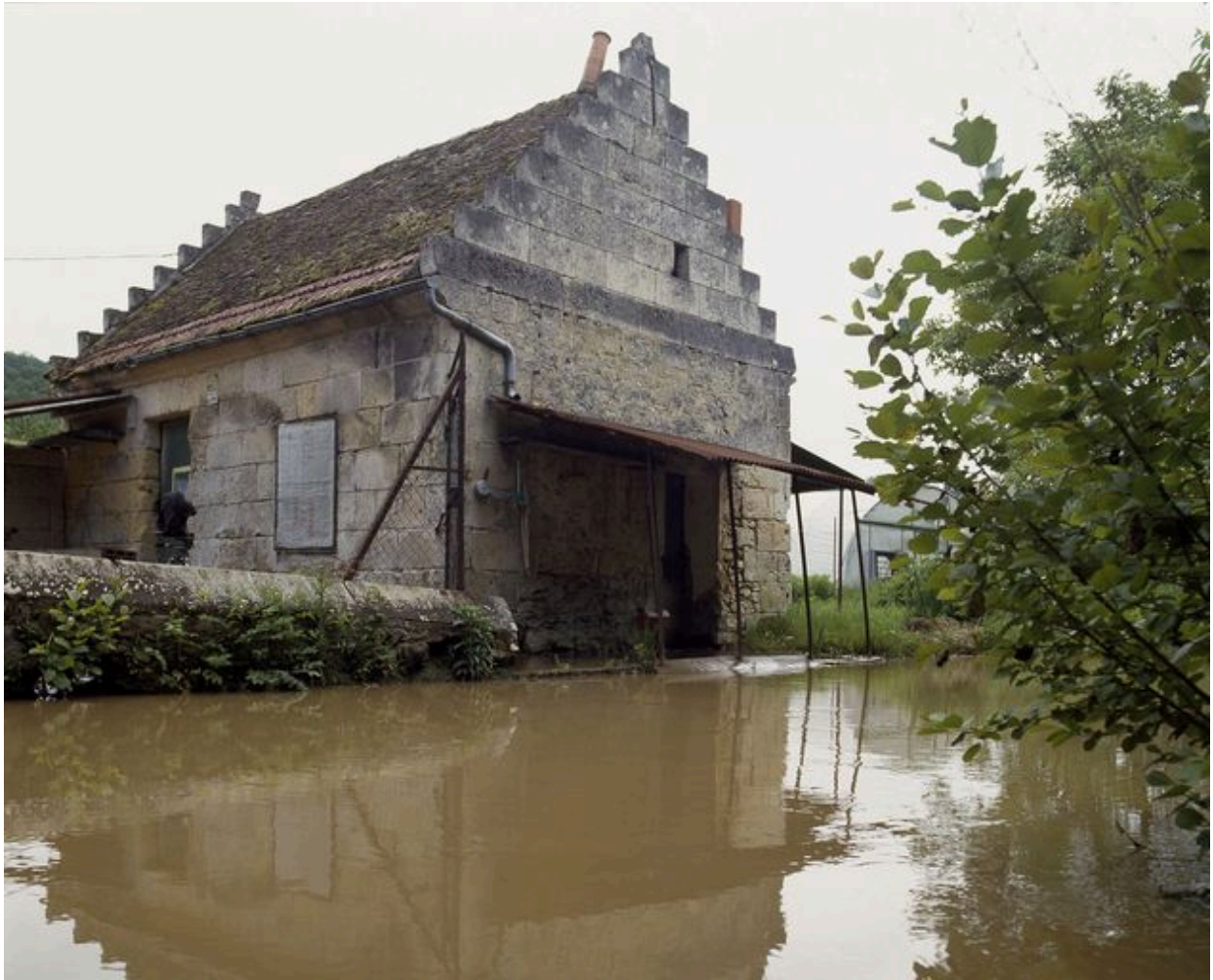
Le bassin de retenue.
