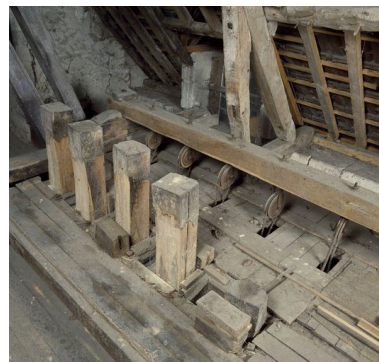
Détail des battors (en comble). Phot. Olivier Coquelle IVR22_19946001197XA
