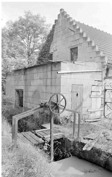
Vanne de décharge. Phot. Benoît Dufournier IVR22_19946001336Z
