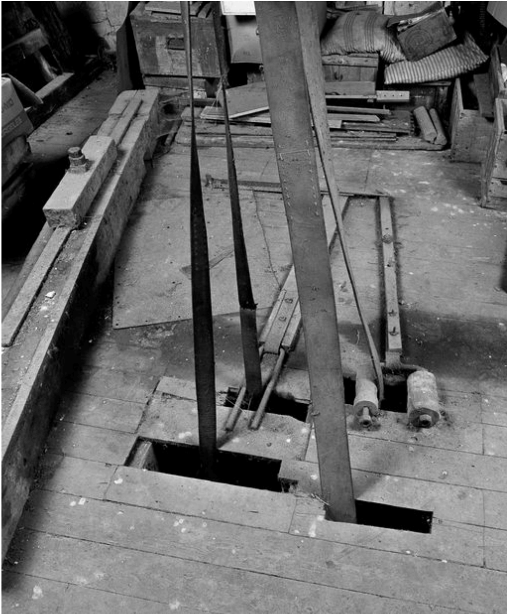
Courroies de transmission, en comble.
