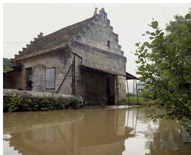
Le bassin de retenue. Phot. Olivier Coquelle IVR22_19946001201XA
