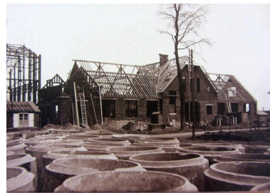
Les bureaux de la sucrerie, 1921 (AD Somme ; 49 Fi 26). Phot. Fournier Bertrand (reproduction) IVR22_20158006172NUCA
