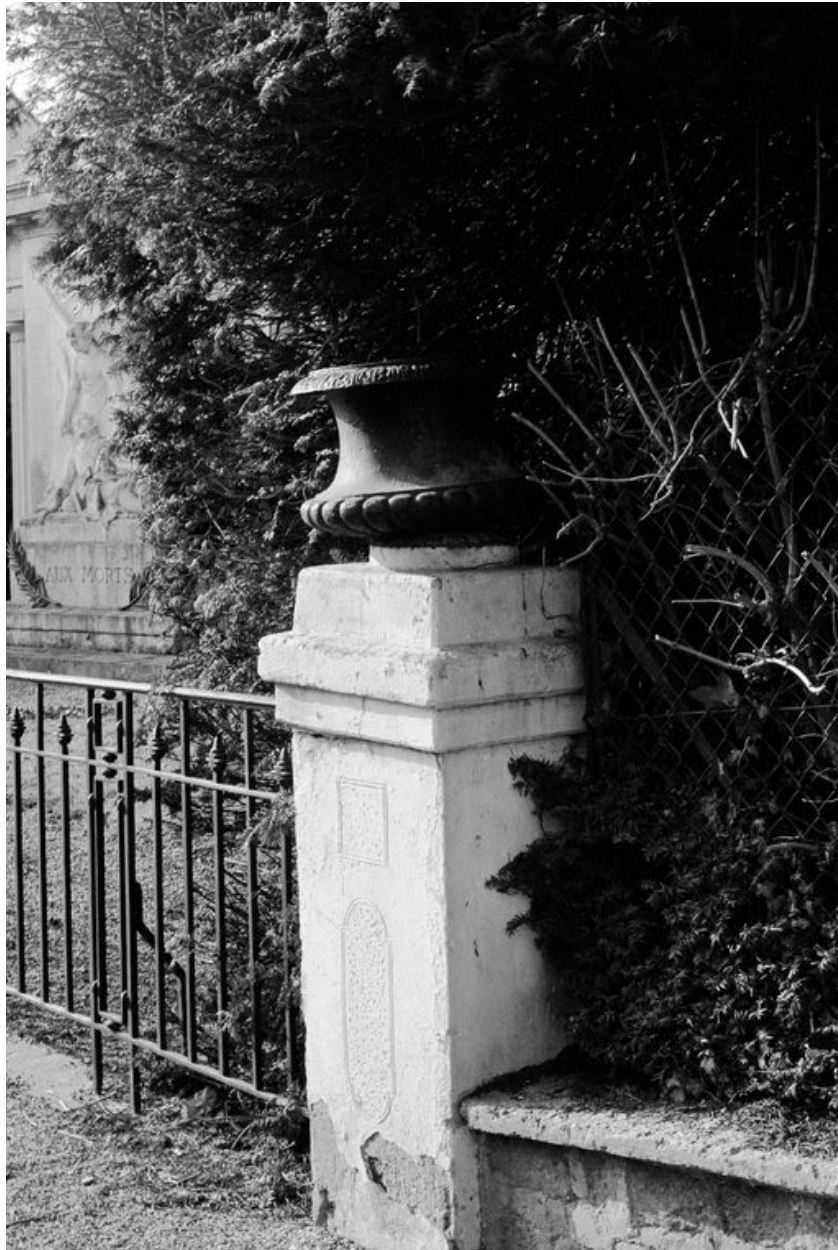
Pile droite de la grille d'accès avec urne en fonte.
