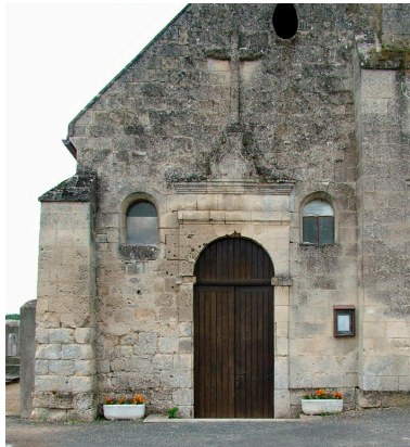
Vue du portail occidental.
