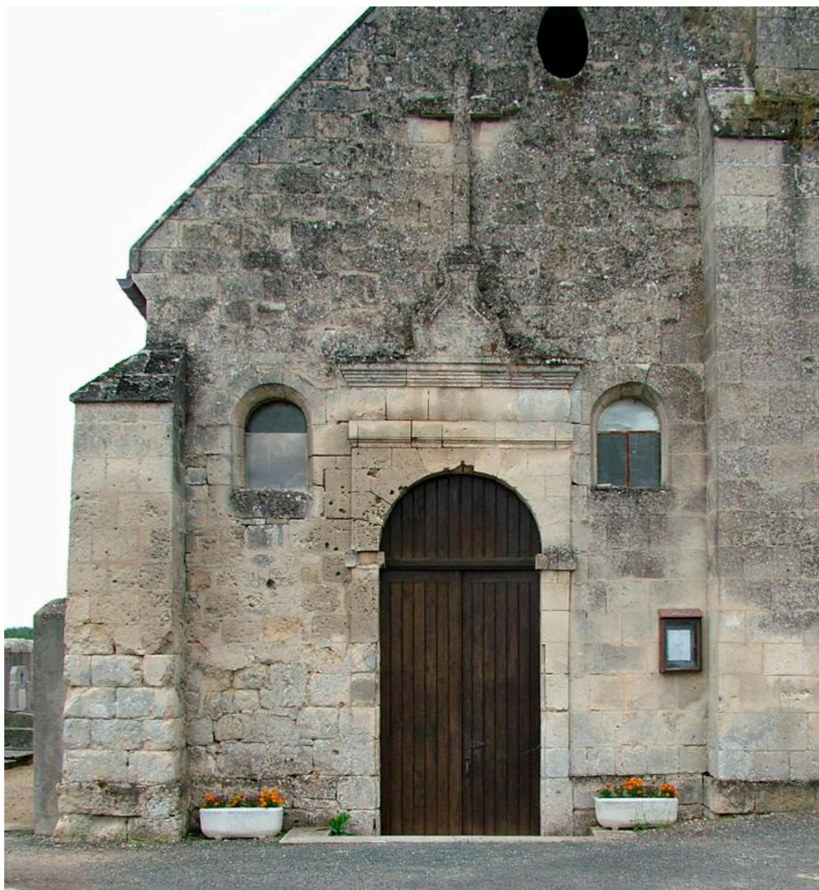
Vue du portail occidental.
