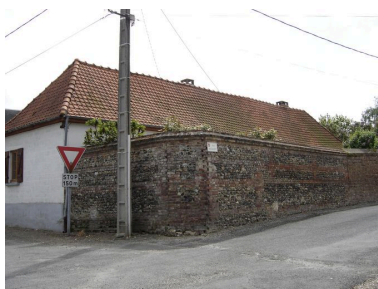
Vue du mur de clôture en briques et silex. Phot. Inès Guérin IVR22_20058005767NUCA
