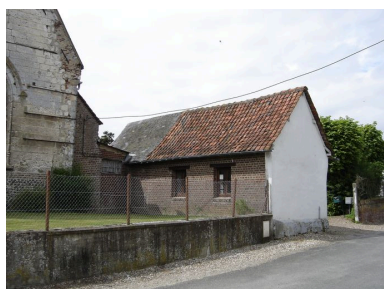
Vue postérieure des anciens bâtiments agricoles. Phot. Inès Guérin IVR22_20058005766NUCA
