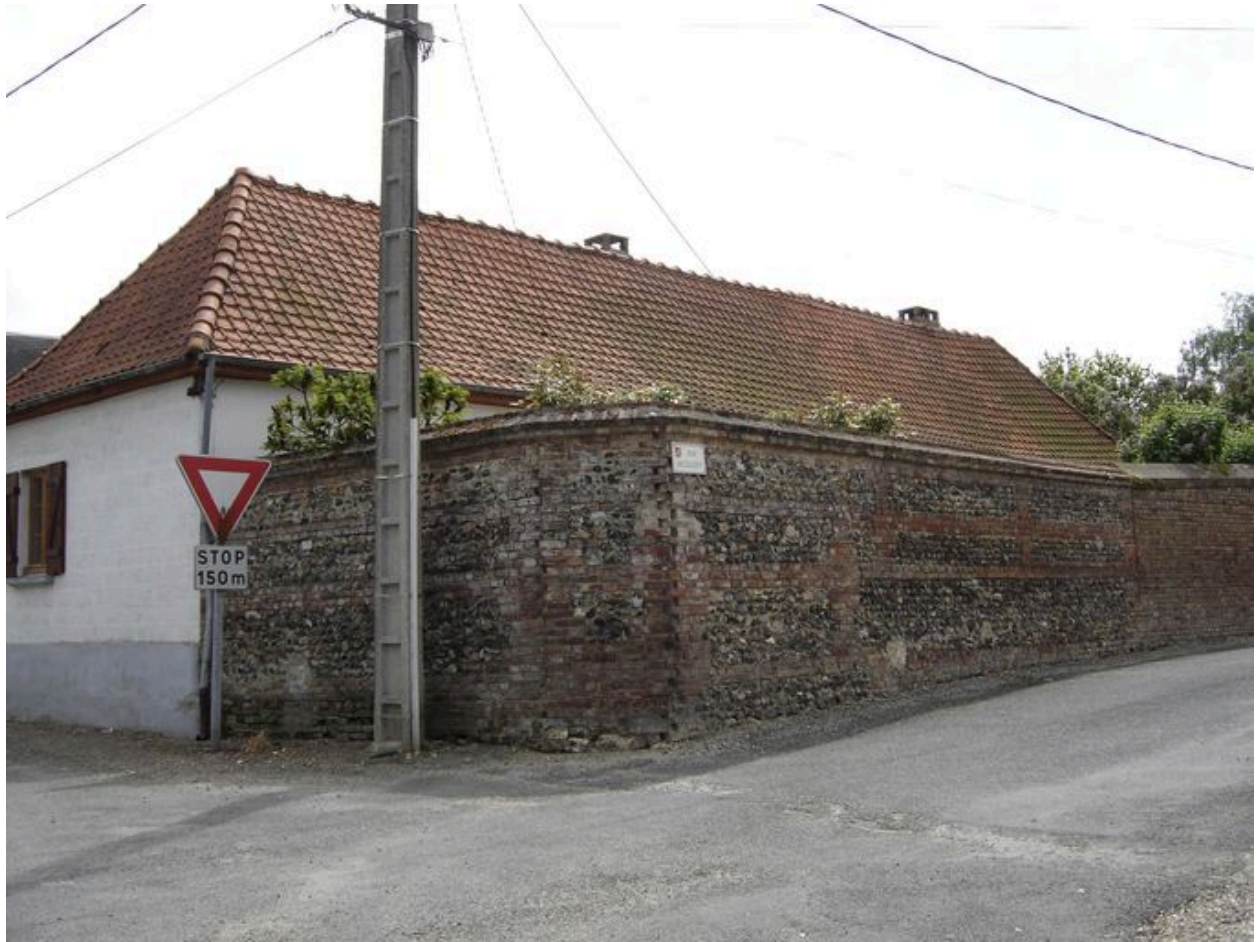
Vue du mur de clôture en briques et silex.
