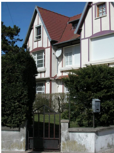
Vue depuis l'arrivée. Phot. Elisabeth Justome IVR22_20058002751NUCA
