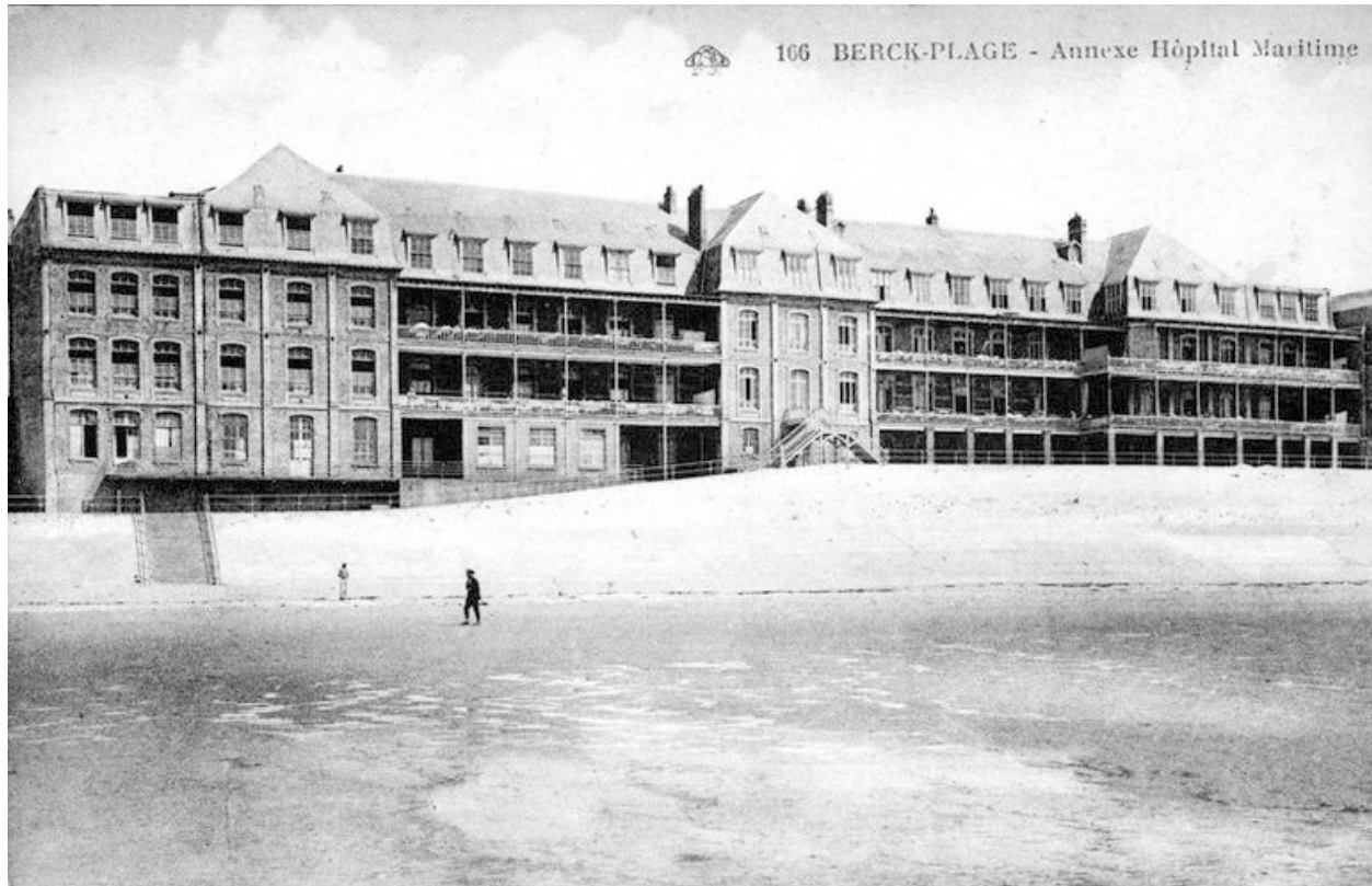
Elévation antérieure telle qu'elle se présentait après les extensions successives du bâtiment primitif au nord et au sud, vue générale prise de face. Carte postale, 2e quart du 20e siècle (coll. part.).
