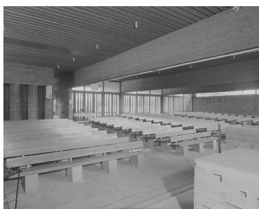
Vue intérieure vers l'est. Phot. Thierry Lefébure IVR22_19968000269V
