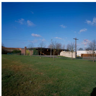
Vue de situation depuis le sud-est. Phot. Thierry Lefébure IVR22_20038000030XA
