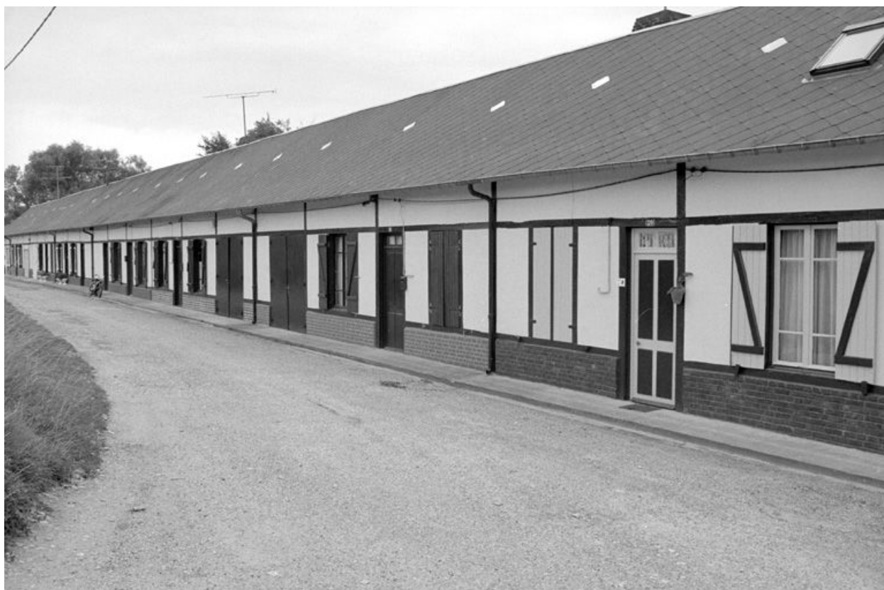
Logements d'ouvriers (cité Rouzelin), vue générale.
