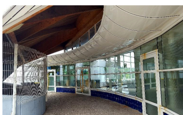
Vue de la terrasse d'entrée, avec vue sur les bassins. Phot. Laurence Schlosser IVR32_20176005066NUCA
