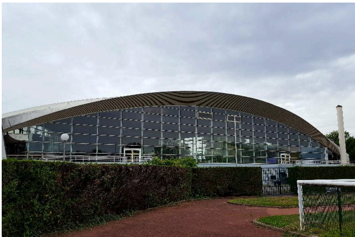
Vue de la façade est depuis le stade.
