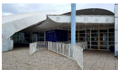
Vue de l'entrée de la piscine. Phot. Laurence Schlosser IVR32_20176005065NUCA
