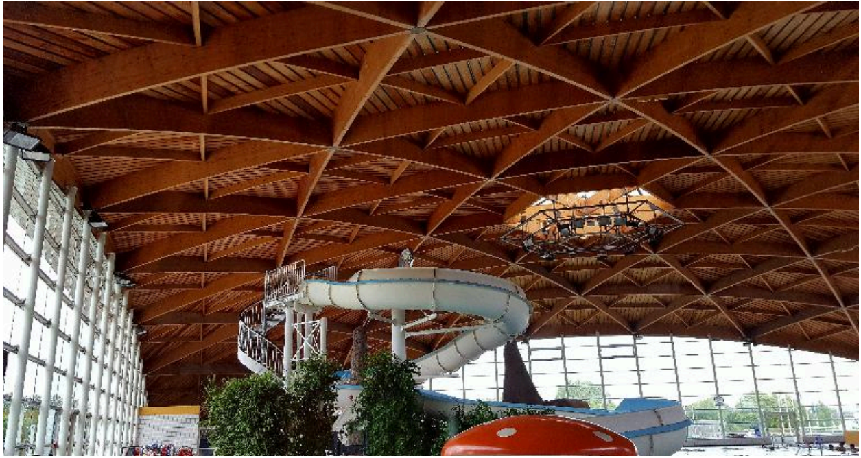
Vue de la voûte en bois lamellé collé.
