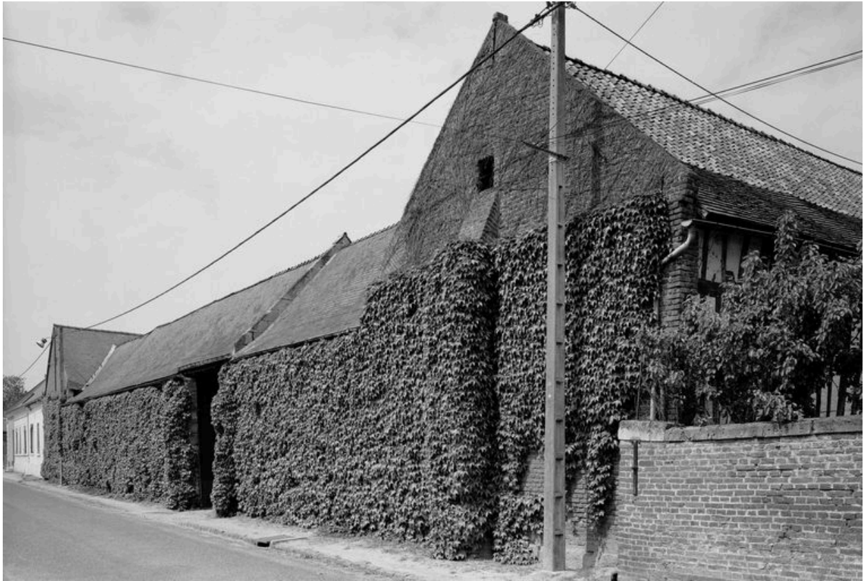
Vue générale sur rue.
