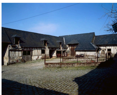
Bergerie et grange, depuis la cour. Phot. Jean-Michel Perrin IVR22_19856000719XA
