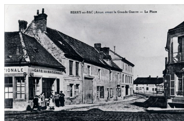
Vue ancienne de la place depuis la rue principale (coll. part). Phot. Inès Guérin IVR22_20030202590NUCAB
