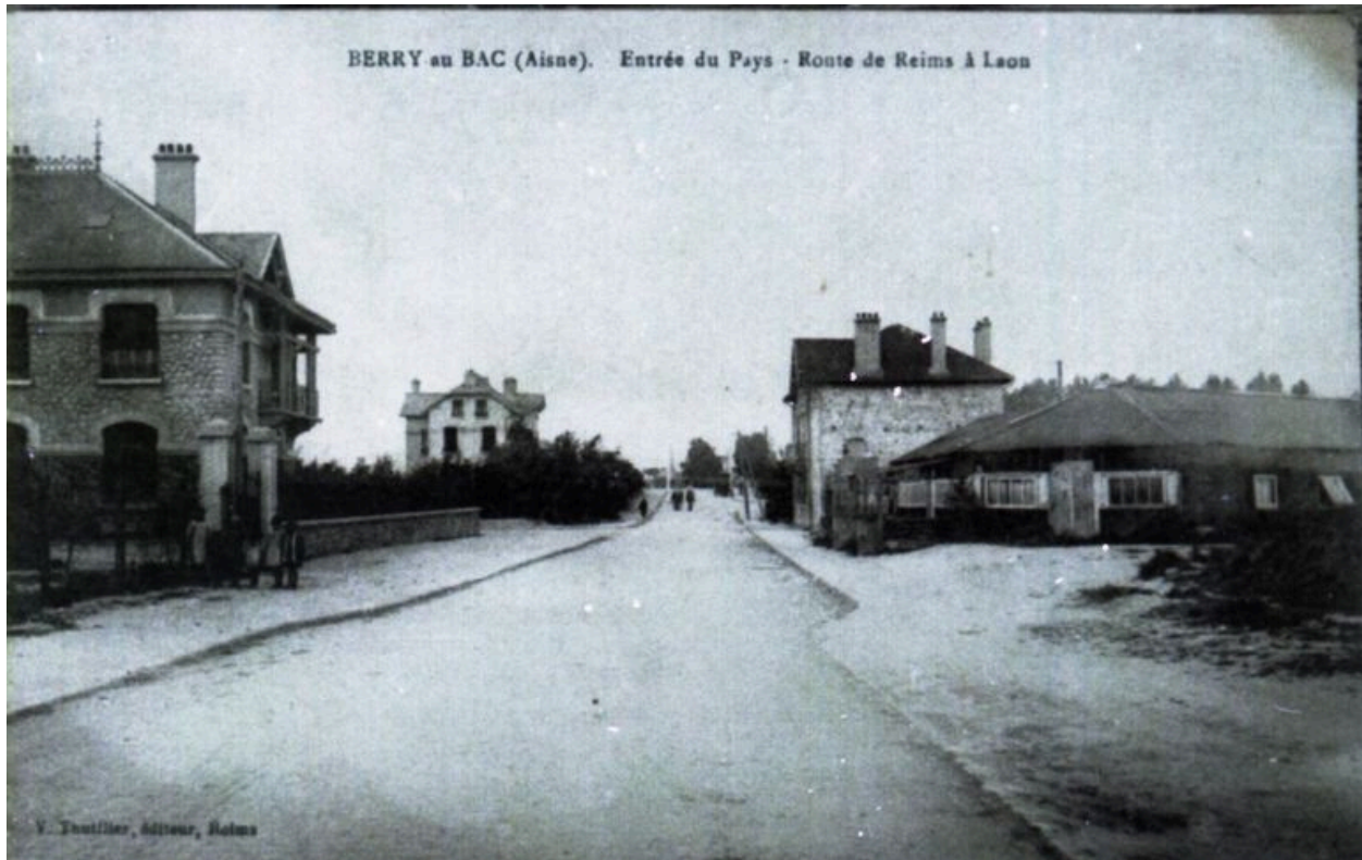
Entrée du village lors de la reconstruction (coll. part).
