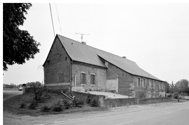
Le logis, depuis le nord-est. Phot. Thierry Lefébure IVR22_19930200449V
