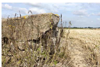
Angle sud-est. Détail Phot. Jean-Marc Ramette IVR31_20145904595NUCA
