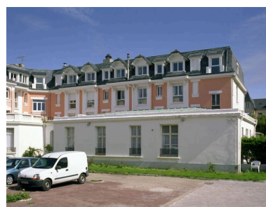
Corps de logis donnant sur la rue Eugène-Trigoulet, élévation postérieure. Phot. Pierre Thibaut IVR31_20076200034XE
