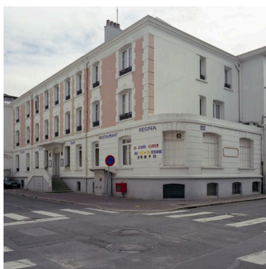
Corps de logis le plus ancien correspondant à celui de la villa de la Santé, élévation sur la rue de Lhomel, vue de trois-quarts droit. Phot. Pierre Thibaut IVR31_20096200048XE
