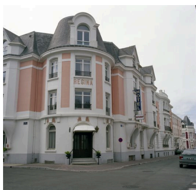
Elévisions sur les rues de Lhomel et Eugène-Trigoulet, vue angulaire montrant l'enfilade des façades donnant sur la rue de Lhomel. Phot. Pierre Thibaut IVR31_20076200036XE
