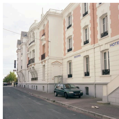
Elévation sur la rue de Lhomel, vue prise en enfilade en regardant vers l'est. Phot. Pierre Thibaut IVR31_20096200047XE
