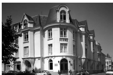
Vue générale en 1981. Phot. Eric Dessert IVR31_19816203711X
