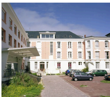
Corps de logis donnant sur la rue de Lhomel, élévation postérieure. Phot. Pierre Thibaut IVR31_20076200032XE
