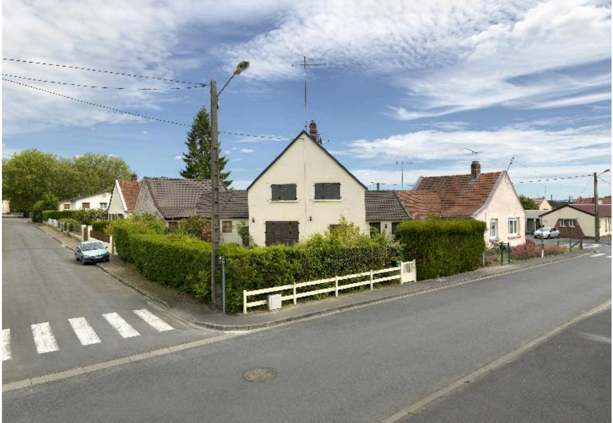
Maison à trois unités d'habitation, type à living-room (1-3, rue de Reims).
