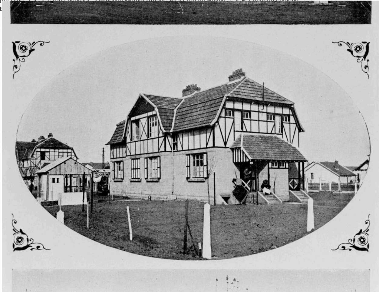
Cité de Tergnier. Maison de quatre logements de quatre pièces. Type Rolland. In L'Oeuvre de reconstitution et la solidarité française, 1925, p. 216.
