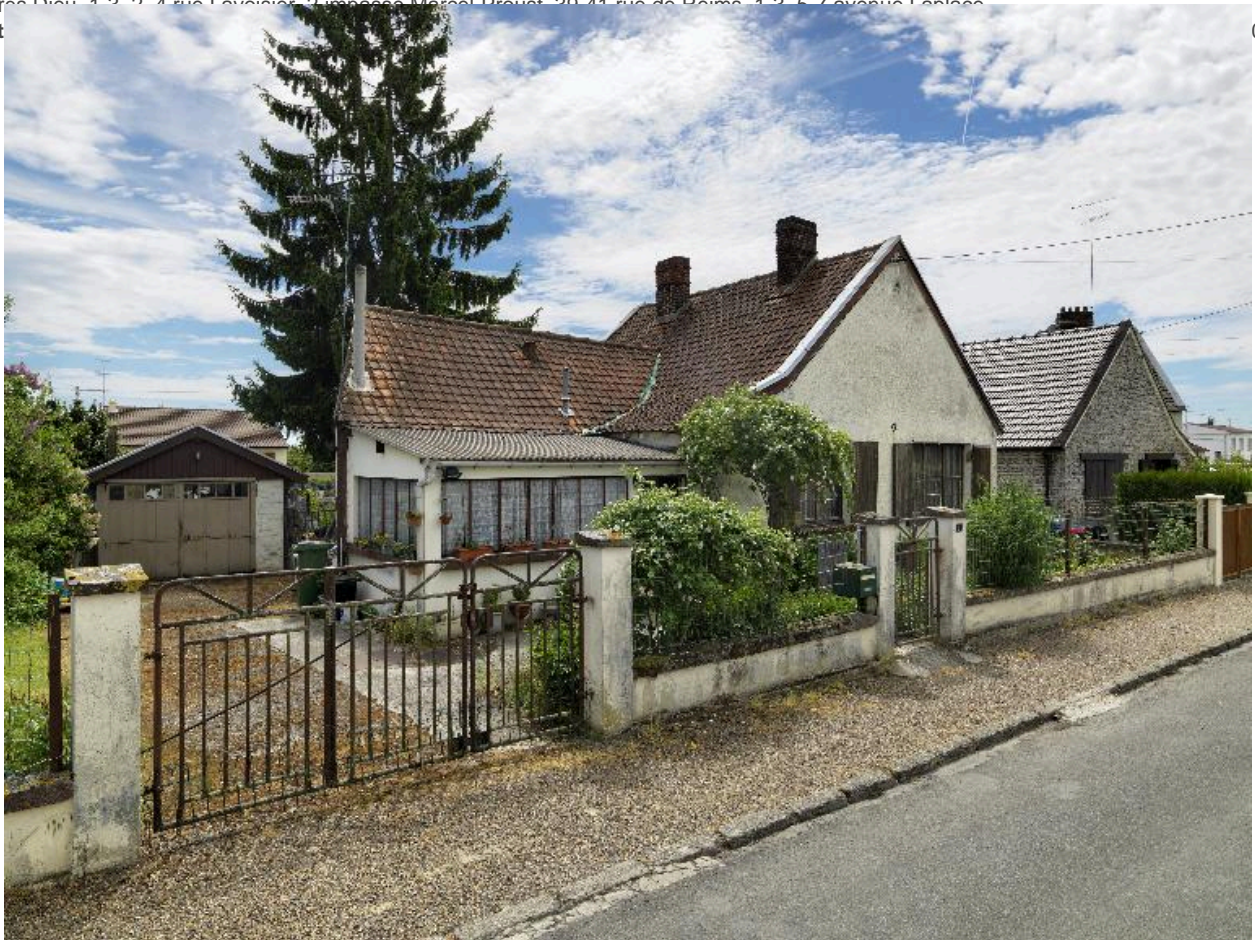
Maison à living-room, vue de trois quarts (1 rue de Reims).
