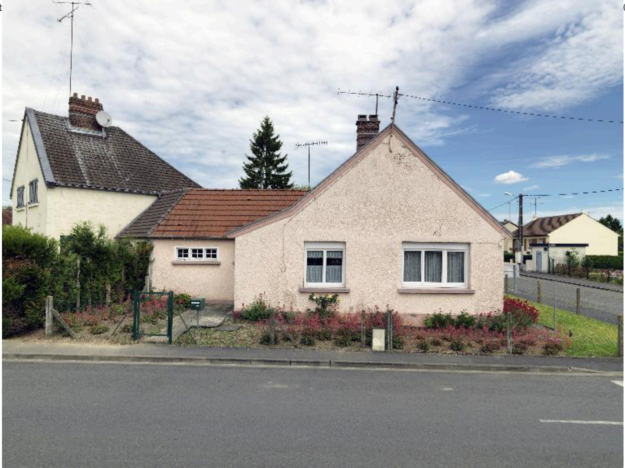
Maison à living-room (angle de la rue Edouard-Branly et de la rue Famille Sauvage).
