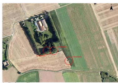
Situation de l'ensemble sur une photographie aérienne de 2009 Phot. Jean-Marc Ramette IVR32_20175900244NUCA
