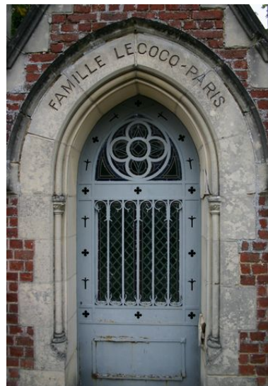
Détail de la porte en arc brisé, appareillée de pierre de taille. Phot. Caroline Vincent IVR22_20068001446NUCA
