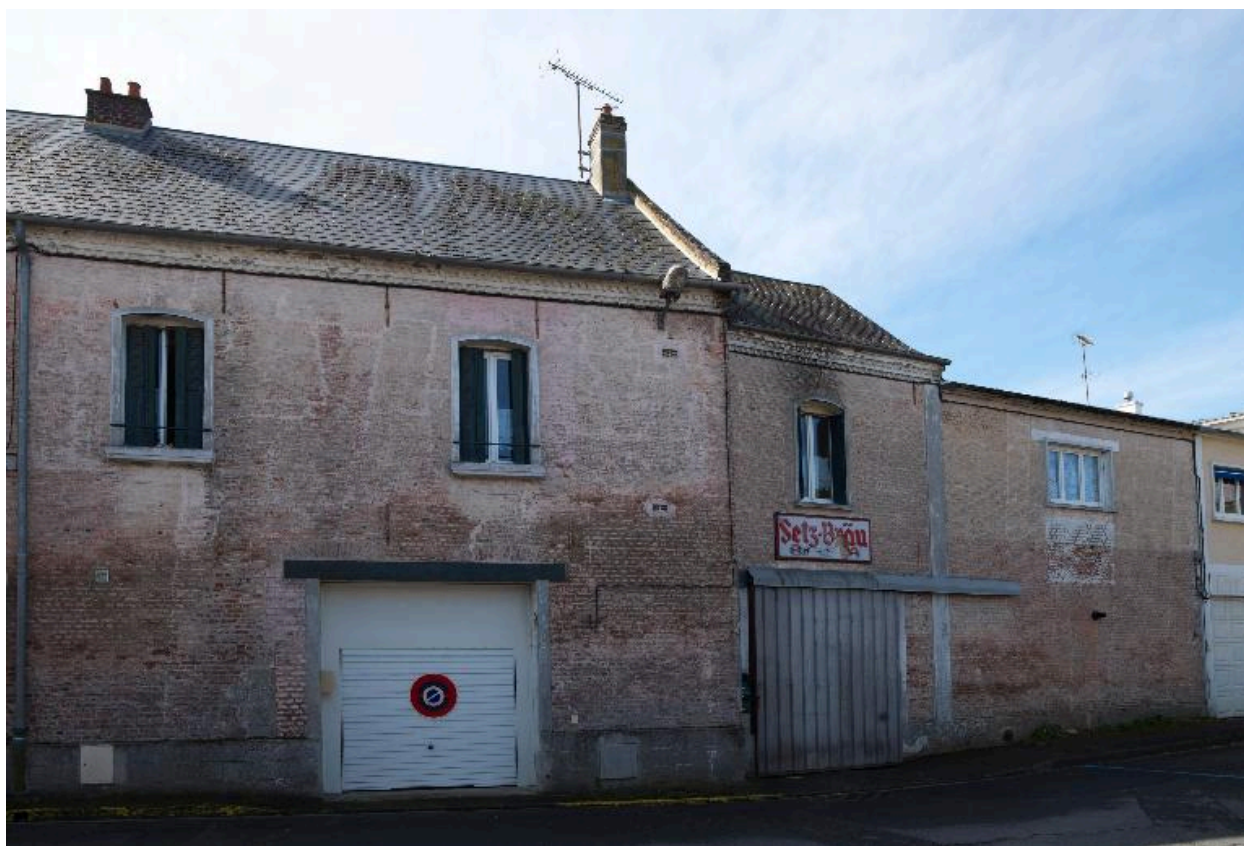
Vue de la partie est de la façade sud.
