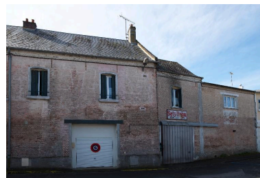
Vue de la partie est de la façade sud. Phot. Marie-Laure Monnehay-Vulliet IVR32_20168000119NUC2A
