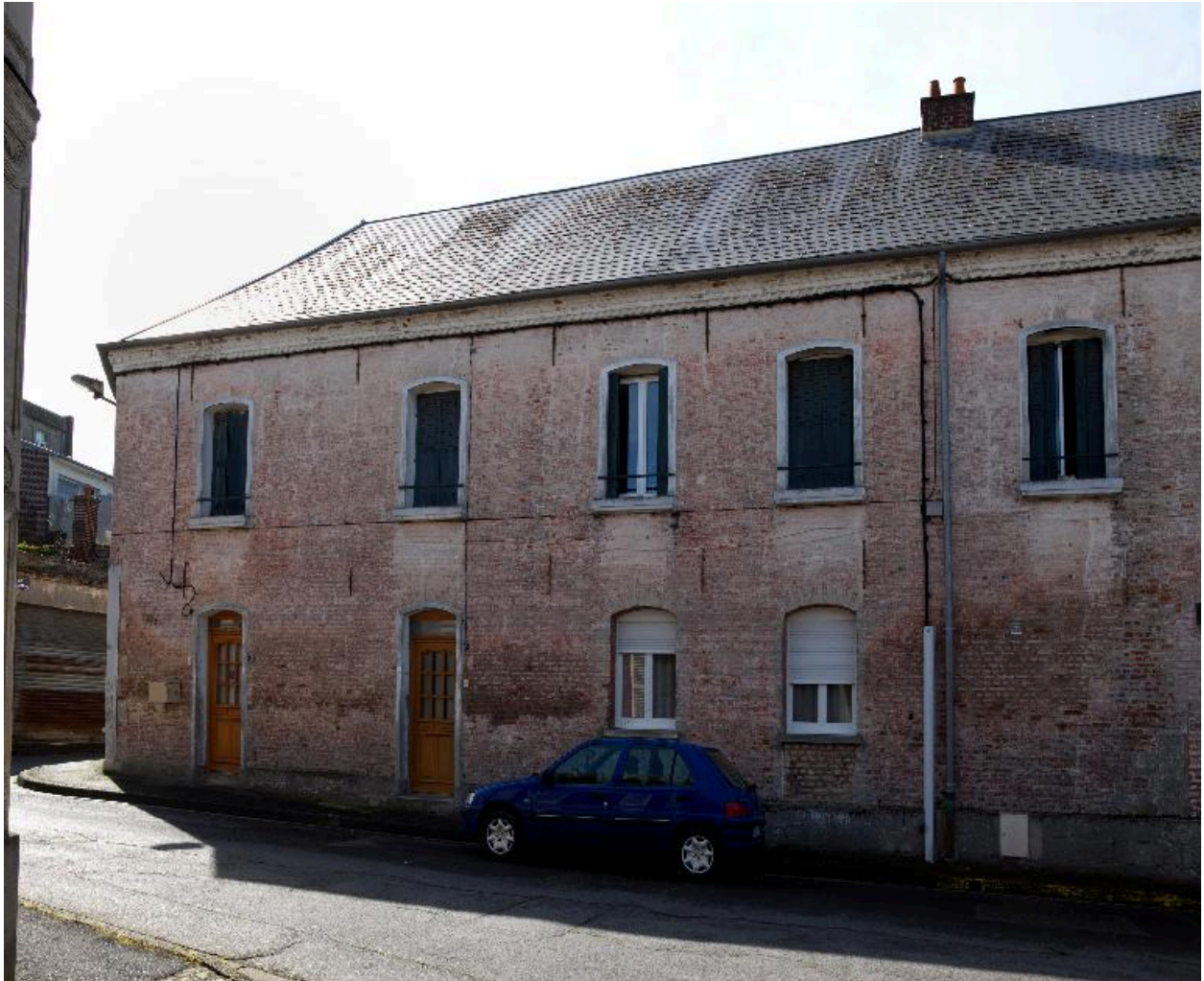
Vue de la façade sud.
