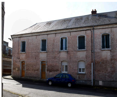
Vue de la façade sud.
