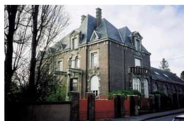
Vue générale. Phot. Gilles-Henri Bailly IVR22_20158005868NUCA
