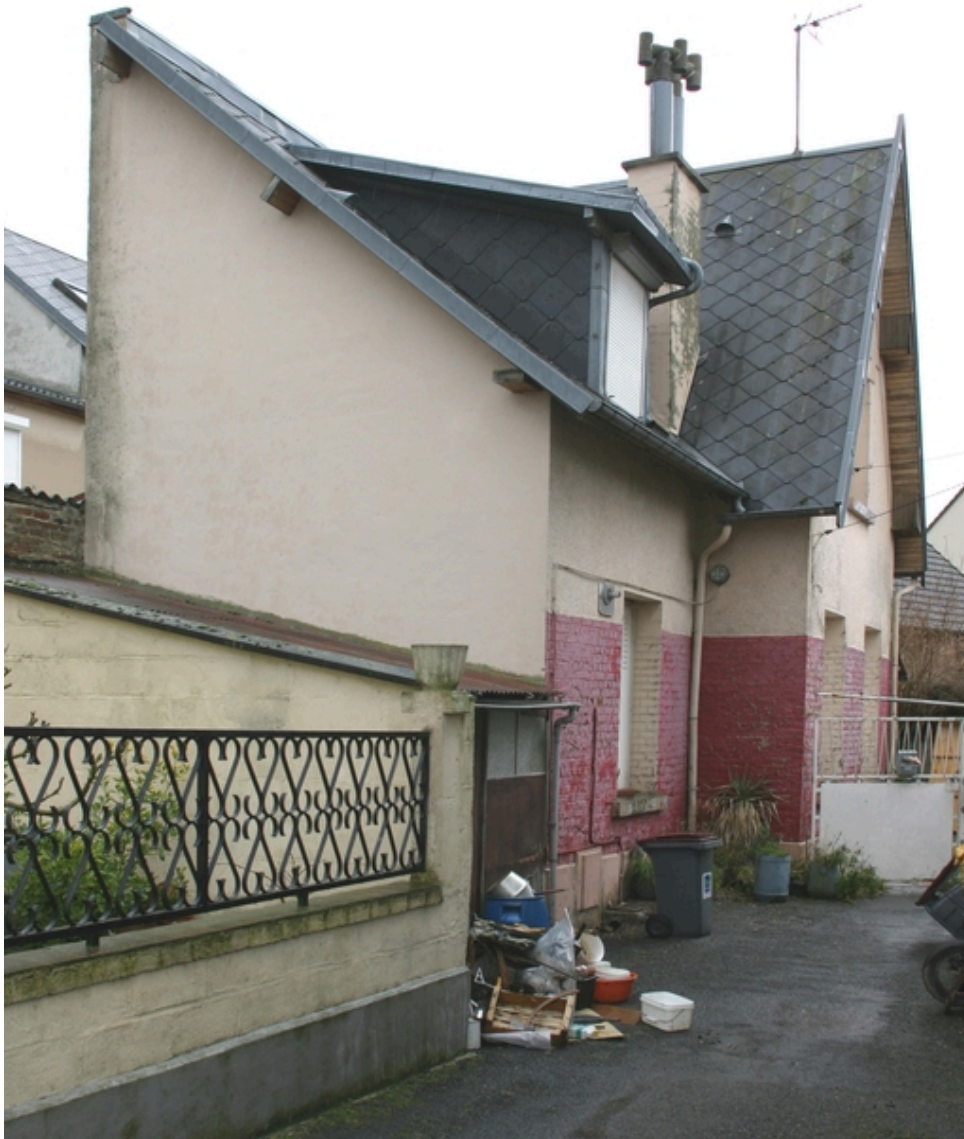
Logement de type isolé implanté entre les deux groupes du chemin d'Itencourt et de la rue de La Fère.
