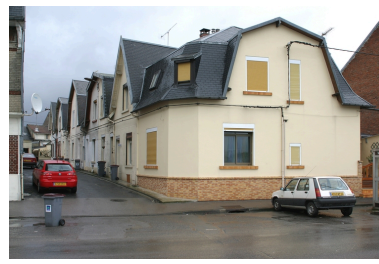
Logements implantés rue de La Fère. Phot. Frédéric Pillet IVR22_20060205211NUCA
