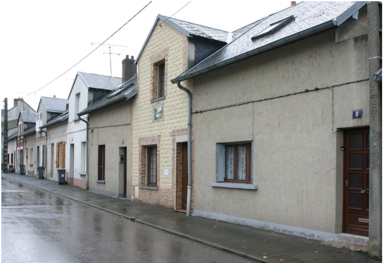
Logements implantés chemin d'Itencourt.
