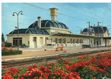
La gare de Tergnier. Vue depuis les quais. Carte postale, 3e quart 20e siècle (coll. part.). Phot. Isabelle Barbedor IVR32_20170205624NUCA
