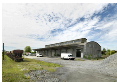
Halle de marchandises de type 2bis à 10 portes. Vue depuis le nord-est. Phot. Thierry Lefébure IVR32_20170200177NUC2A
