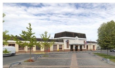
Vue générale, façade principale. Phot. Thierry Lefébure IVR32_20170200168NUC2A
