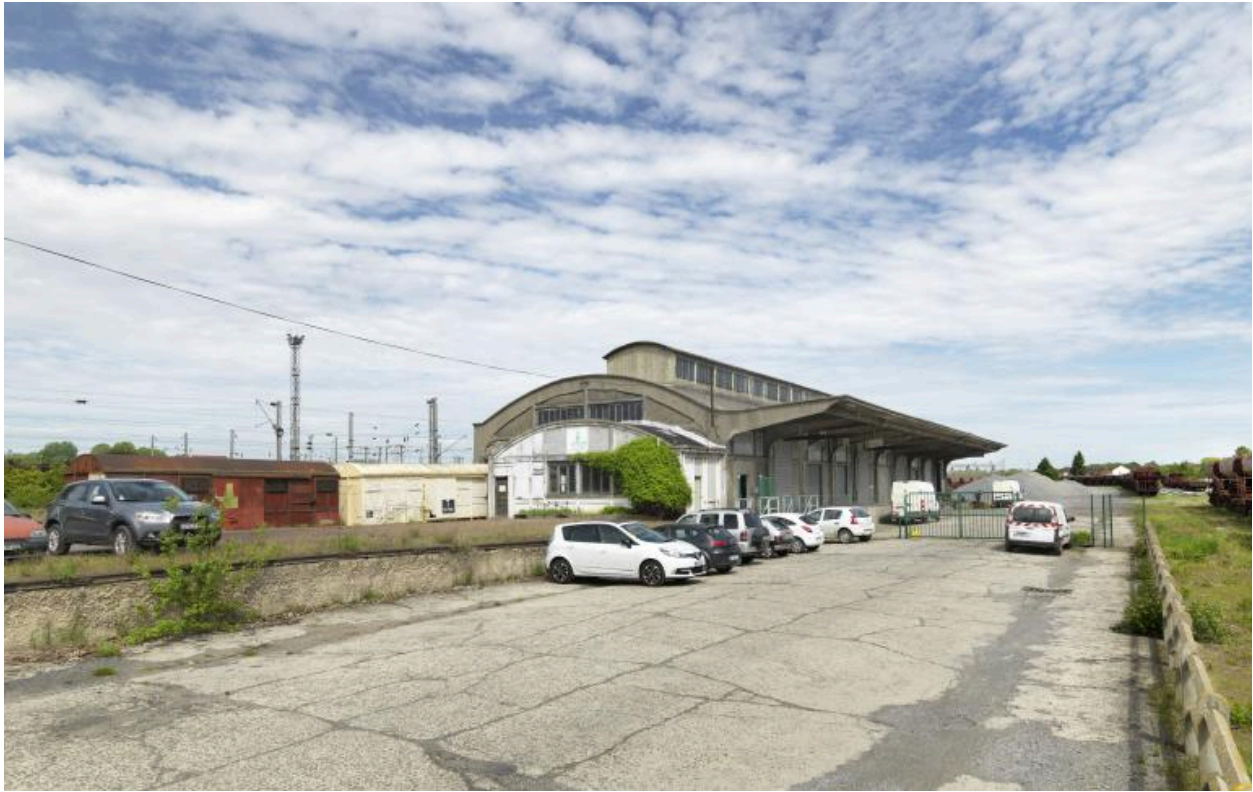
Halle de marchandises de type 2bis à 10 portes. Vue depuis le sud-est.
