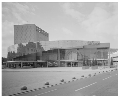
Vue d'ensemble. Phot. Irwin Leullier IVR22_19978000615V
