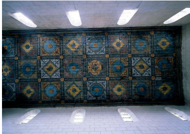
Vue générale. Phot. Thierry Lefébure IVR22_19990201750PA
