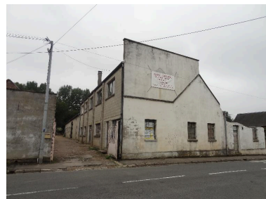
Vue générale. Phot. Frédéric-Nicolas Kocourek IVR22_20158005929NUCA
