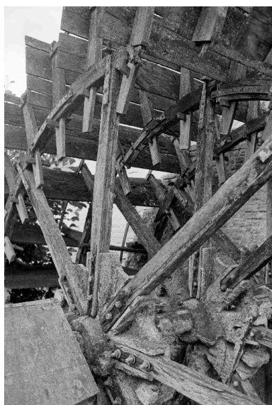
Roue hydraulique. Phot. Francis Dubuc IVR22_19908000625Z
