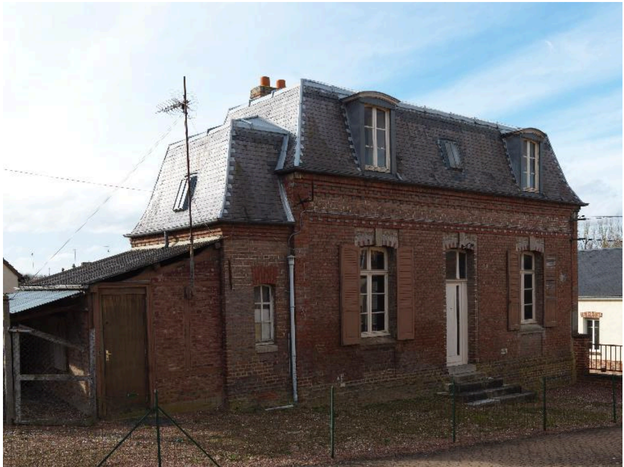
Vue d'un des logements.
