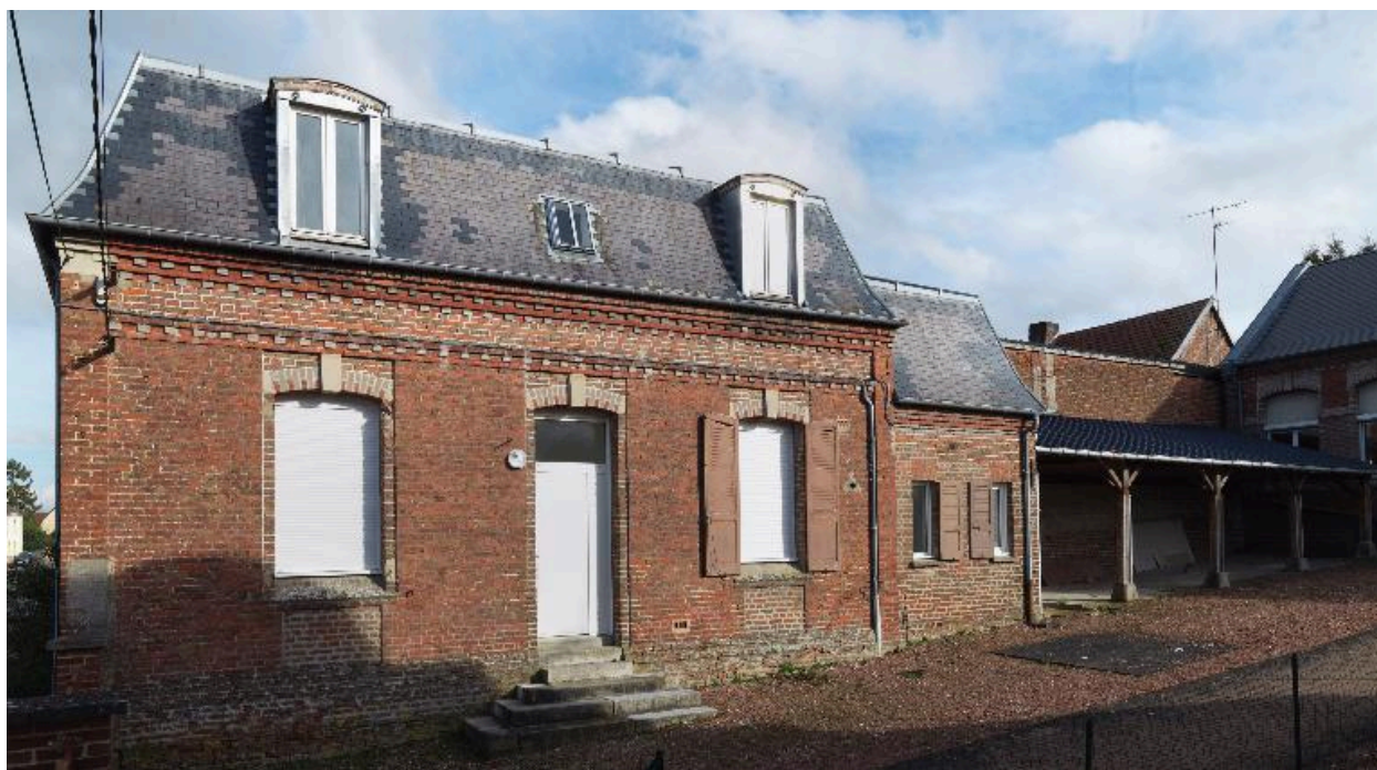
Vue générale d'un des anciens logements, à gauche de la grille d'entrée.
