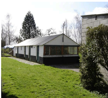
Vue des annexes. Phot. Inès Guérin IVR22_20058005137NUCA
