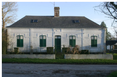
Vue générale du logis. Phot. Irwin Leullier IVR22_20078000166NUCA
