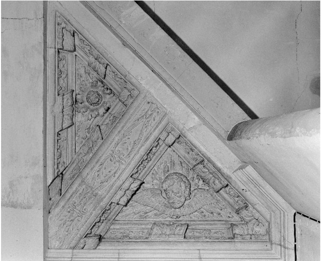
Premier étage de l'aile sud du logis : vue de la voûte qui surmontait au 16e siècle le palier du petit escalier droit.
