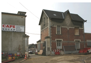
Entrée du site et bureau. Phot. Frédéric Pillet IVR22_20070205064NUCA
