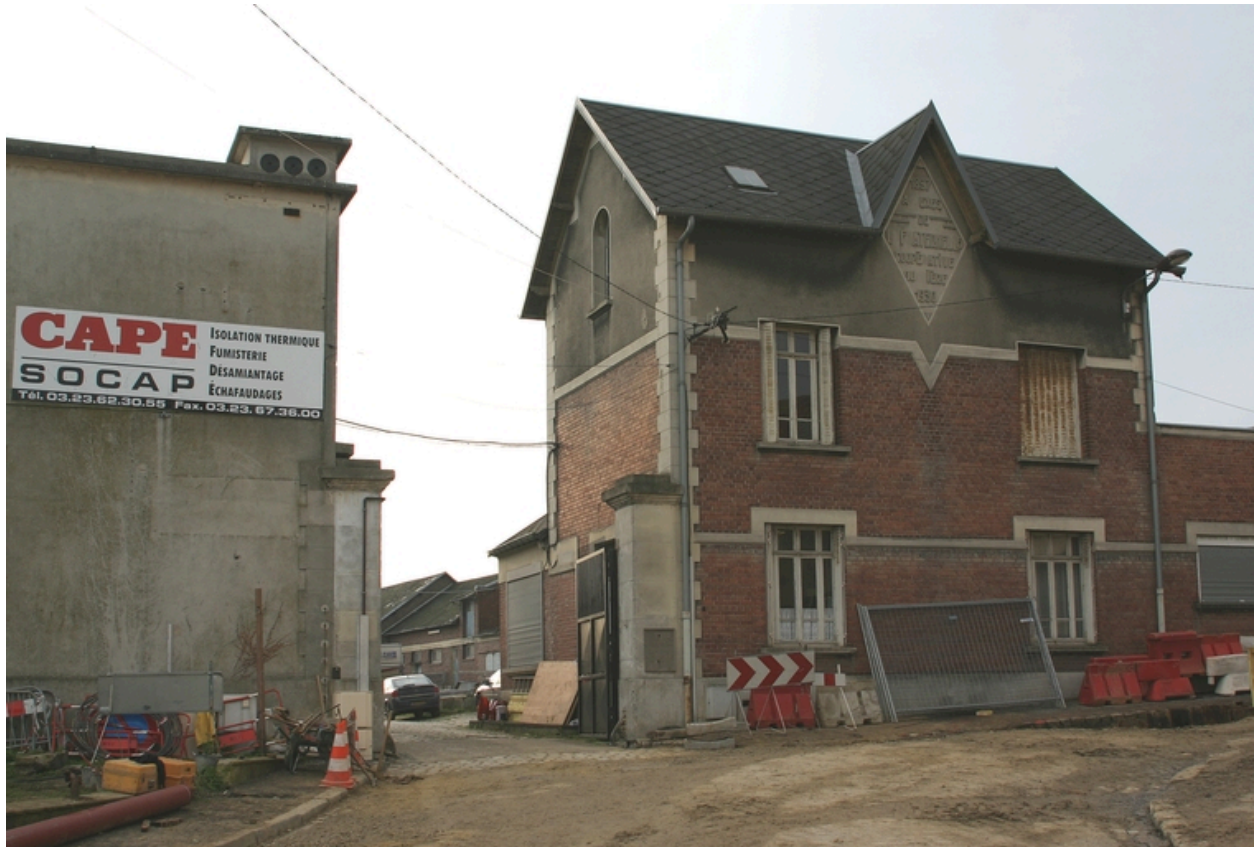
Entrée du site et bureau.
