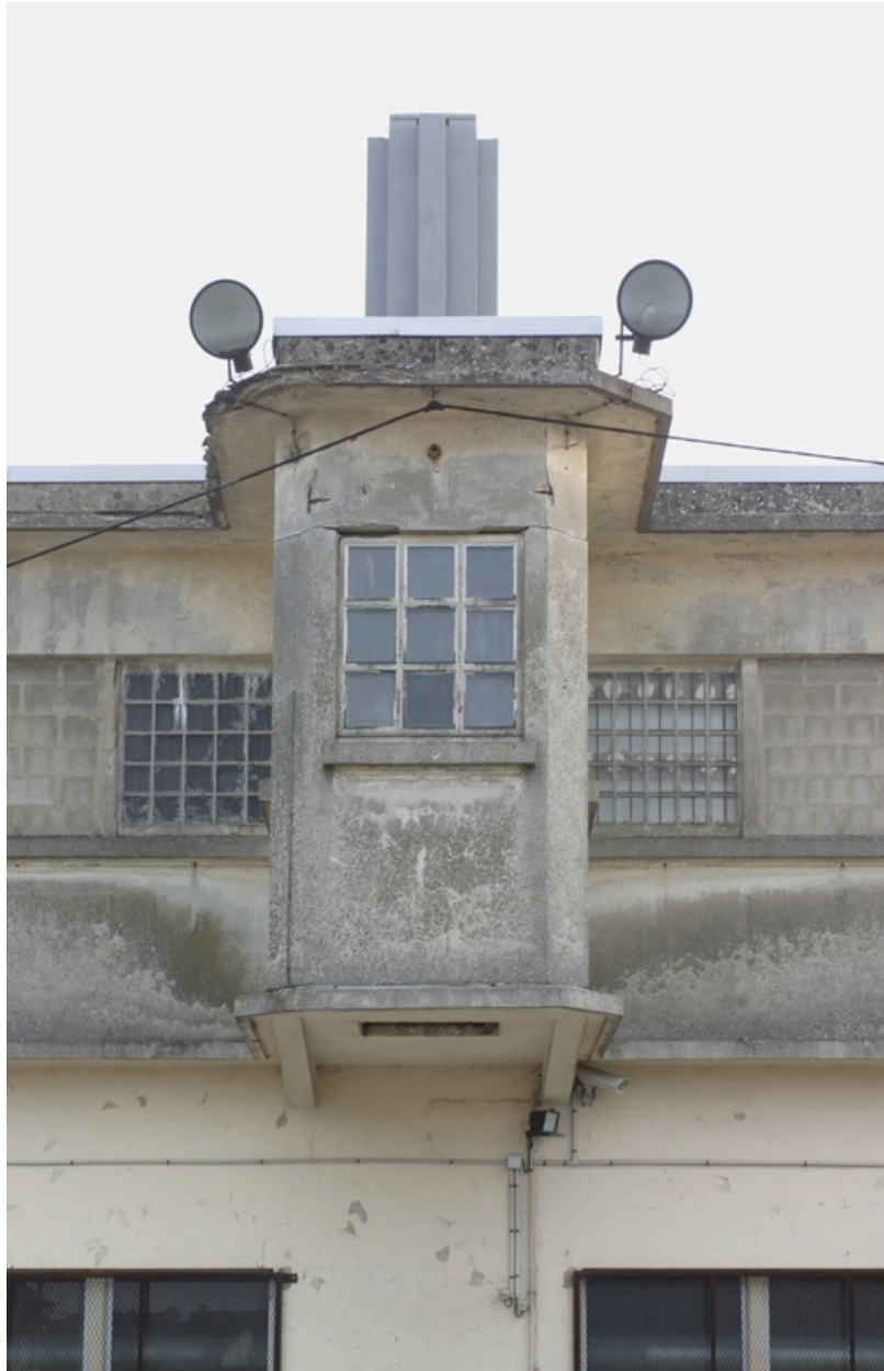
Détail de la façade de la boulangerie (aménagement destiné à l'élévation des sacs de farine vers l'étage).
