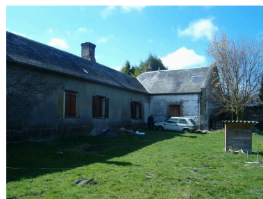
Vue postérieure de la maison accompagnée de la cave à cidre. Phot. Inès Guérin IVR22_20058005131NUCA
