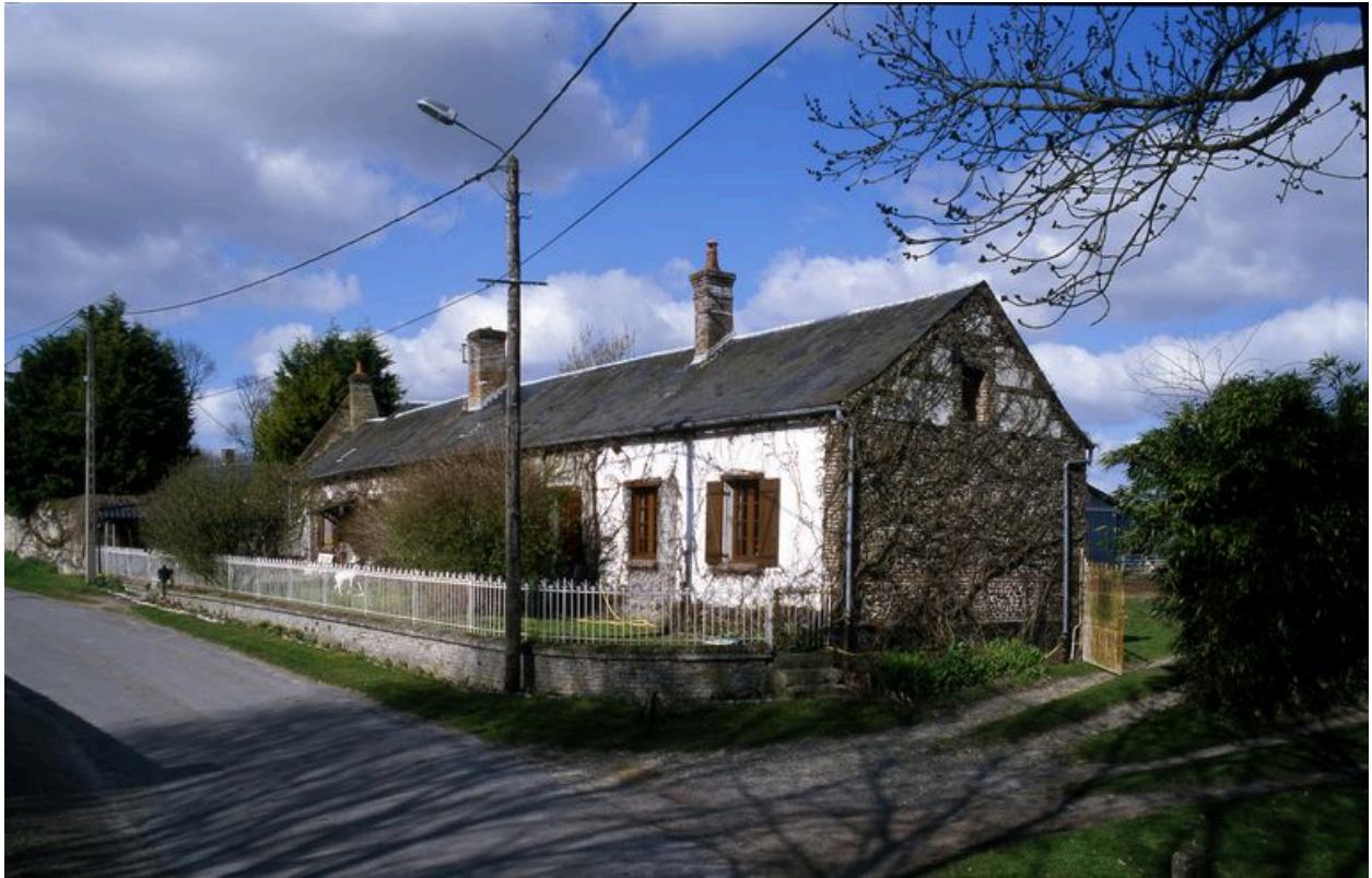
Vue du logis depuis la rue.
