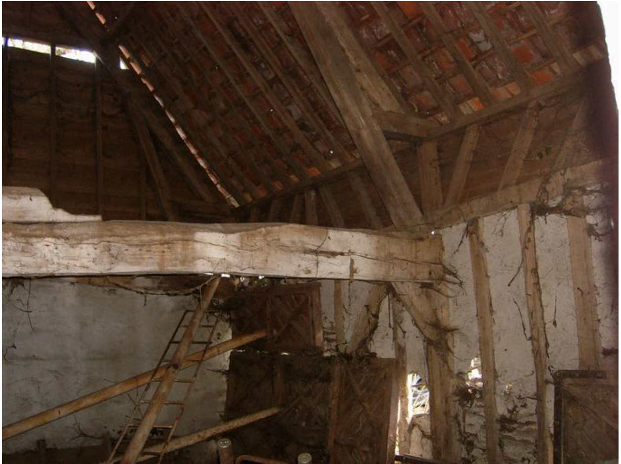
Vue intérieure de la grange.
