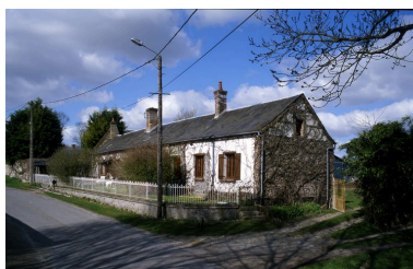
Vue du logis depuis la rue. Phot. Irwin Leullier IVR22_20068000147XA
