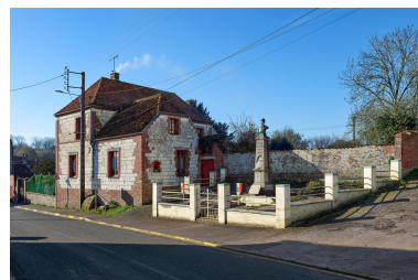
Vue de l'élévation nord. Phot. Thierry Lefébure IVR32_20236200322NUCA
