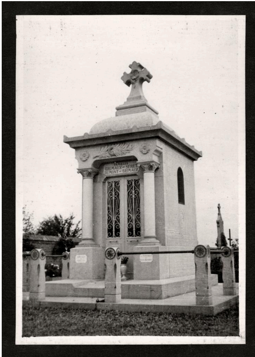
Tombeau des familles Grimaux-Seret et Dumont-Grimaux, élevé dans un cimetière non identifié de la Somme par l'entreprise Louis Timmerman. Photographie, vers 1930 (A.P. Drillancourt).
