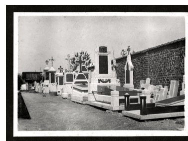
Le dépôt de modèles de tombeaux de l'entreprise Timmerman. Photographie, vers 1925 (A.P. Drillancourt). Phot. Thierry Lefébure IVR32_20218000203NUCA
