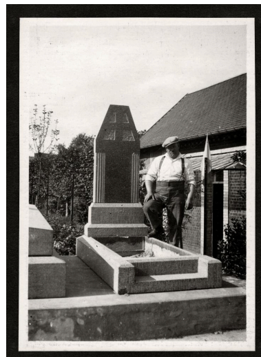
Louis Timmerman posant à côté d'un modèle d'exposition (stèle de style Art Déco) dans le dépôt. Photographie, vers 1930 (A.P. Drillancourt). Phot. Thierry Lefébure IVR32_20218000181NUCA
