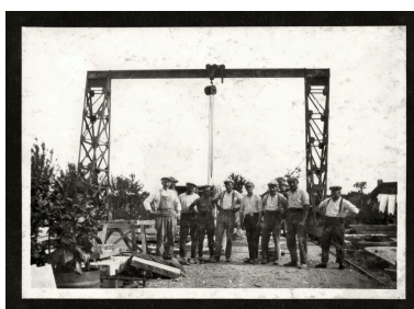
[Le portique et les employés de l'entreprise Louis Timmerman]. Photographie, vers 1930 (A. P. Drillancourt). Phot. Thierry Lefébure IVR32_20218000174NUCA
