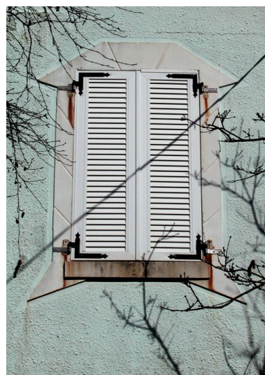
Détail d'une des baies de la maison dite Caravelle. Phot. Elisabeth Justome IVR22_20058003979NUCA
